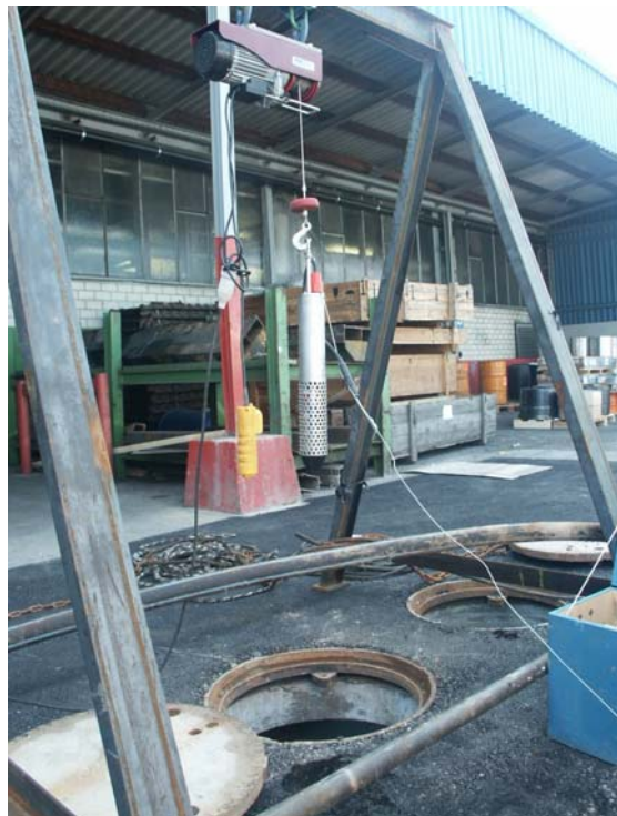
Abbildung 1.1: Hydrochemische Sondierung am Sanierungsbrunnen HWS 26
