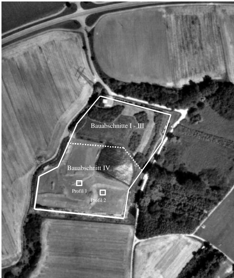
Abb. 8: Luftbild der Deponie Großmehring (Aufnahmedatum: 10.08.1998, Luftbildnummer: 98004/1, M = 1:5000) mit den einzelnen Bauabschnitten und der Lage der beiden Meßprofile (Profil 1 und Profil 2) im Bereich von Bauabschnitt IV.
