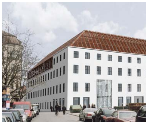
Abb. 9.2: Geplante Stahl-Glas-Konstruktion des Alten Hofes
