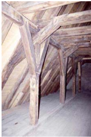
Abb. 9.1: Ursprüngliche Holzkonstruktion des Lorenzistocks im Alten Hof
