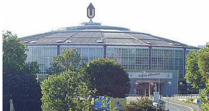
Abb. 3.9: Dortmunder Westfalahalle mit Aluminium-Leistendach
