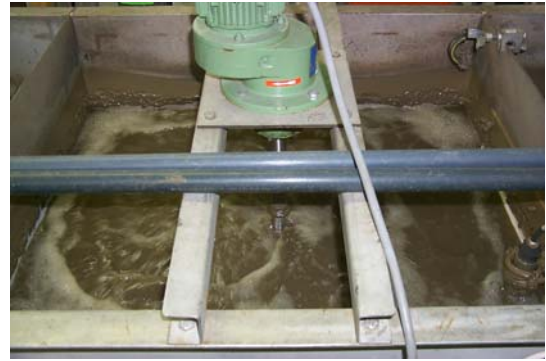
(b) Straße mit Zudosierung
