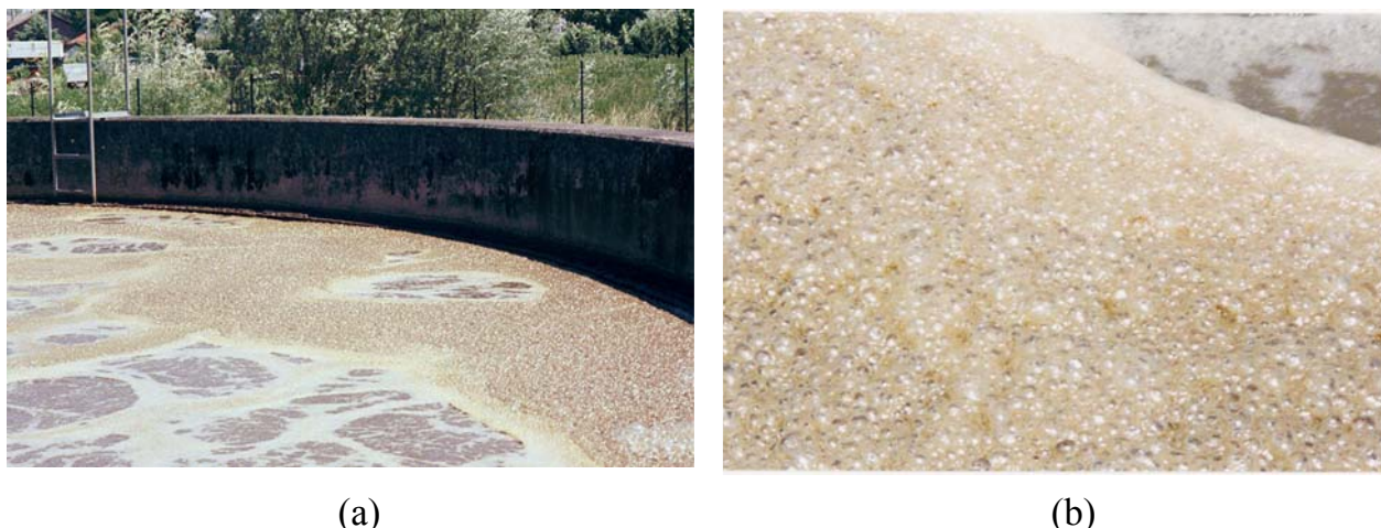
Abbildung 2.1: Erscheinungsbild von Schaum auf der Nitrifikationszone einer kommunalen Kläranlage: a) Übersicht; b) Nahaufnahme.
