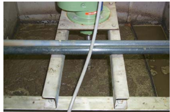
(d) Straße mit Zudosierung
