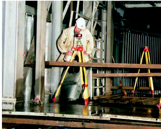
Abbildung 7.3: Positionierung der Stative am Schachtfuß [Ryf]
