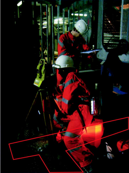
Abbildung 7.7: Tachymeterstandpunkt am Schachtkopf
