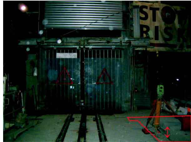
Abbildung 7.8: Tachymeterstandpunkt am Schachtfuß
