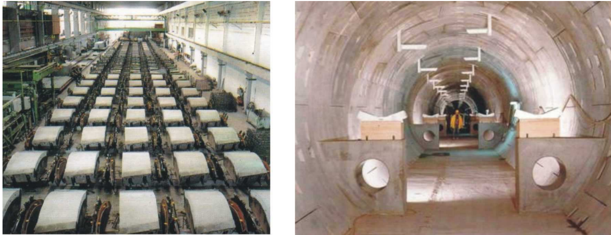
Abbildung 2.5: Tübbinglager und Tunnel mit Stahlfaserbetontübbingauskleidung
