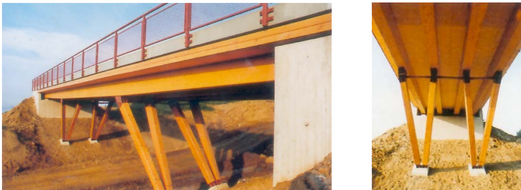
Bild 3.2-1: Straßenbrücke Ruderting; links: Ansicht, rechts: Untersicht. Quelle:[67]
