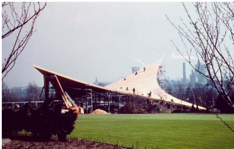
Bild 3.2-9: Pavillon für die Bundesgartenschau in Dortmund (Bauzustand)
