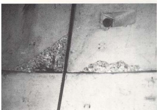
Abb.2-11: Geologieseitige Abplatzungen an der Fugendichtung nach dem zwangsbeanspruchten Einbau
