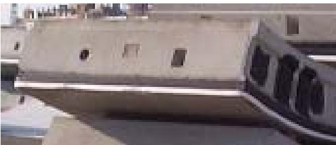
*Abb.7-3: Tübbing mit Dichtungen*
