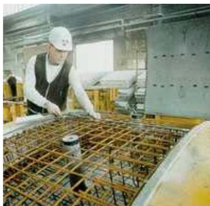
Abb.2-3: Vermessung der Tübbingschalung, Bewehrungskorb und Einbauten
