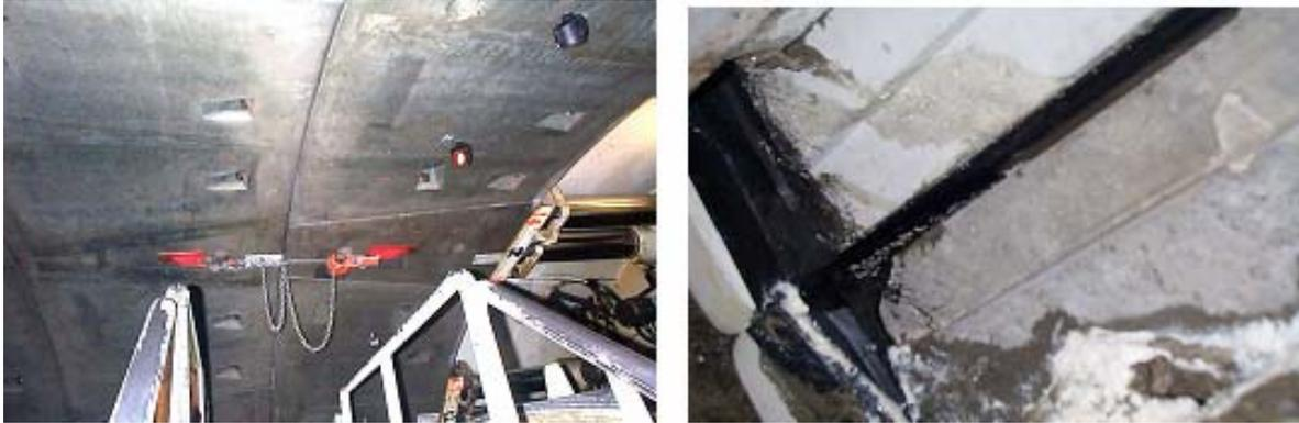
*Abb.7-4: Schlußstein in Einbausituation (Dichtungsproblematik)*
