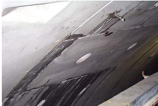
Abb.2-10: Fugendichtung (Ringfuge) (Maidl, B., Herrenknecht, M., Anheuser, L., 1994)
