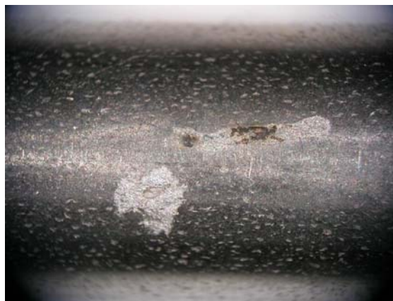
Bild A6: Aufnahmen einer gebeizten Korrosionsstelle, Probe b; Versuchsparameter s. Bild A5
