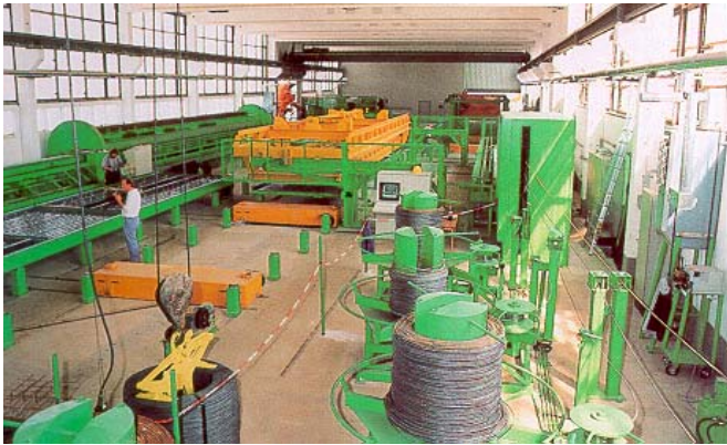
Bild 67 Vorbereitung durch Ablängautomaten für Bewehrungsseisen
