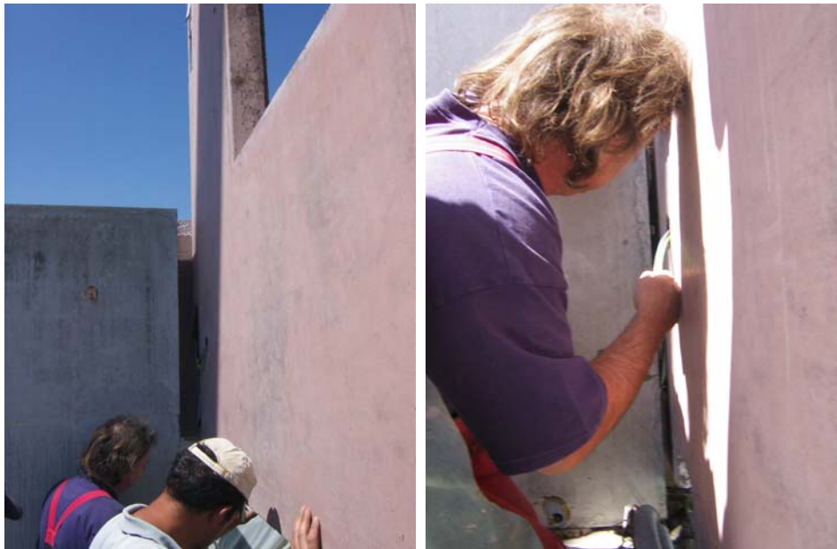
Bild 361-362 problemloses Einfahren der tonnenschweren Wandelemente, präzise Fugenausbildung
