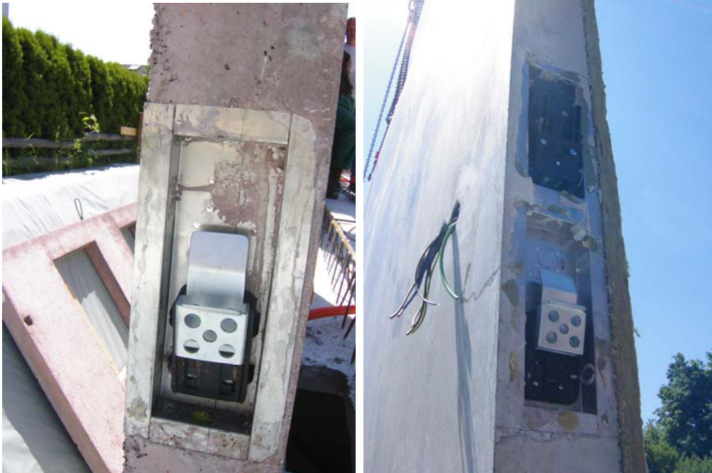
Bild 357-358 Hochlastverbinder in Einlegebuchen zur Vorzentrierung in Vollbetonwand eingebaut
