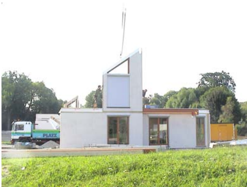
Bild 262 Setzen der ersten Giebelelemente
