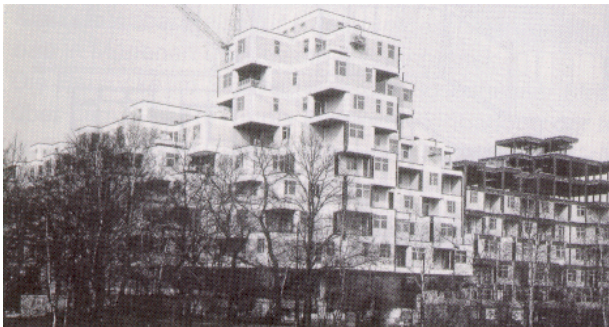
Bild 159 Ansicht des Demonstrativbaus in Wulfen
