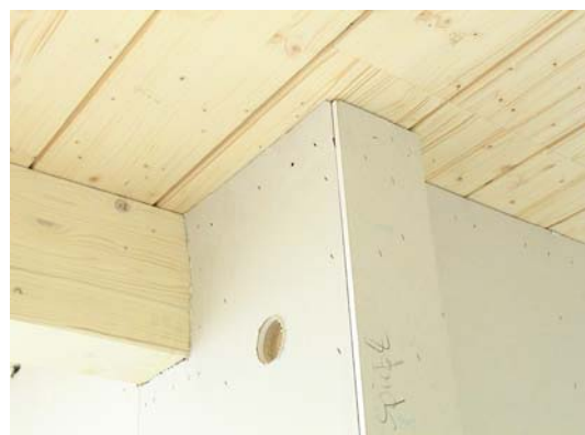
Bild 310 Anschlüsse an Wand und Sturzbereichs
