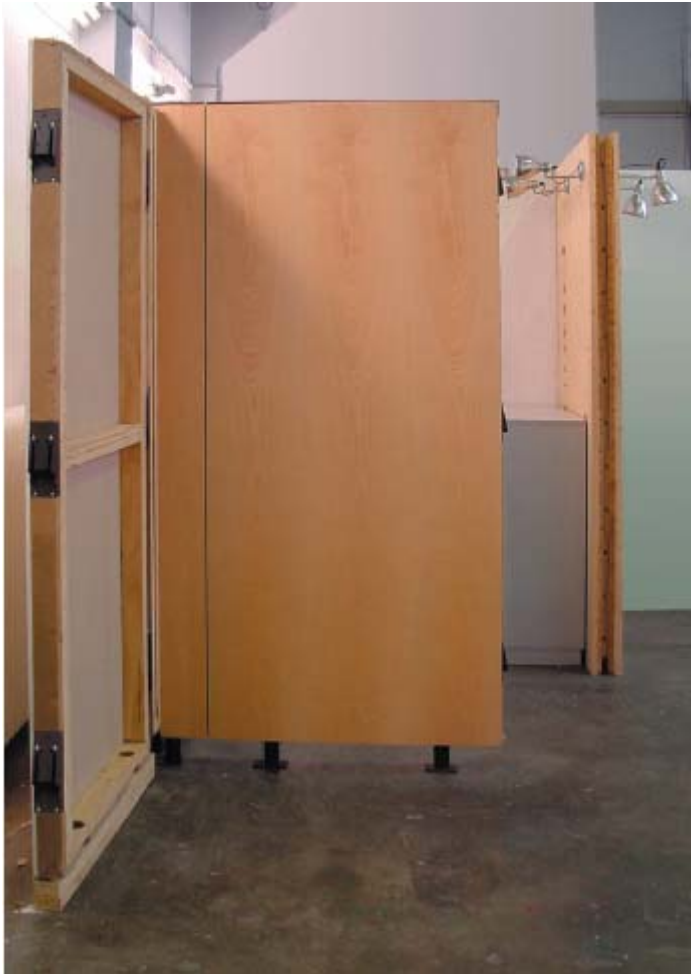
Bild 416 Eckstück der ersten Prototypenwand, noch ohne Stecksockel
