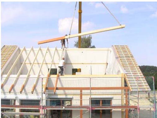
Bild 266 Setzen von Sonderteilen zum Vordach
