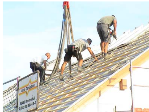
Bild 267 Fixieren der vorgefertigten Dachelemente
