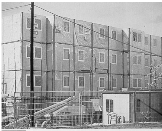
Bild 169-170 vollständig vorgefertigte Raumzellen
