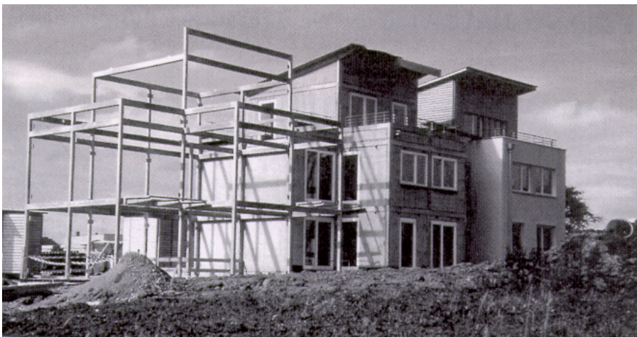
Bild 164 Stahlhäuser in Skelettbauweise der Fa. Dywidag
