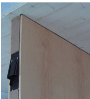
Bild 417-418 erste Prototypenserie der zweischaligen Wandelemente, hier Decken und Bodenanschluss mit patentierten Justierfüßen und Schnellverbindern
