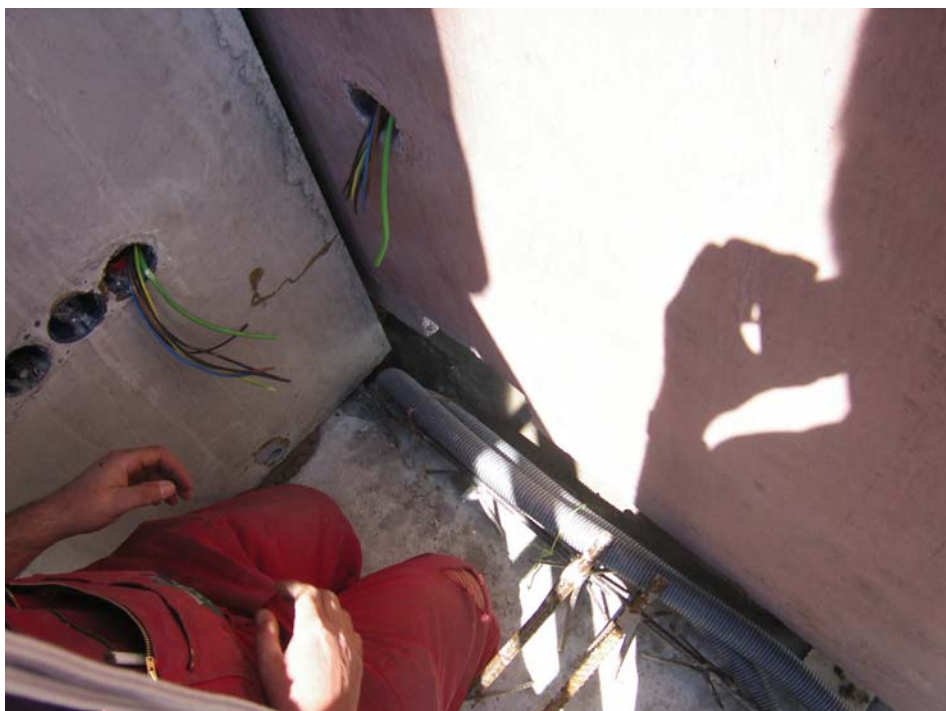
Bild 363 Anschlussfertige Installationen. Die Wandoberflächen könnten in diesem Fall bereits malerfertig sein
