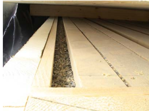
Bild 308 Aufsicht auf ein verfülltes Lignotrend
