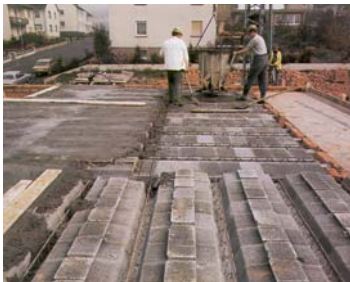
Bild 72-73 Balkendecke mit Zwischenbauteilen
