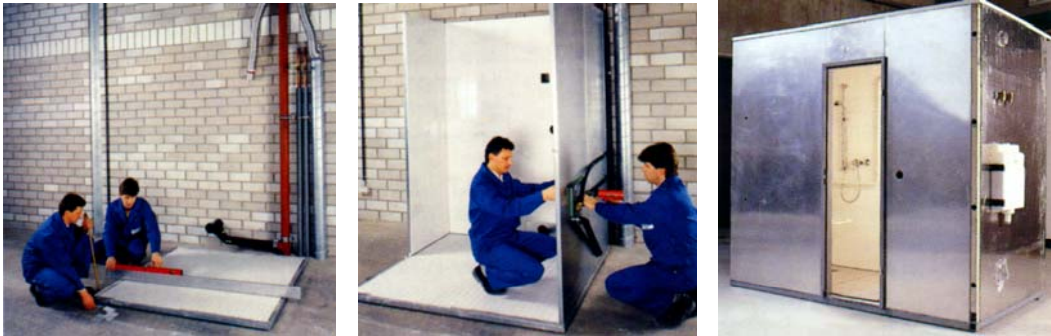
Bild 404 anschlussfertige Raummodule aus PUR- Blechpanelen
