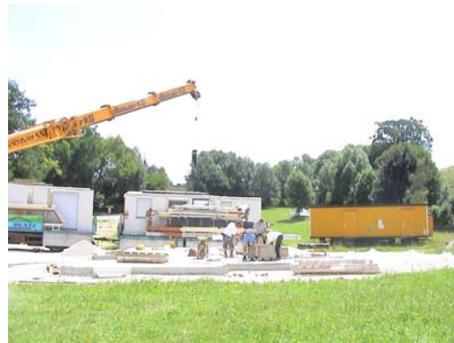
Bild 251 Positionierung Kran, entladen LKW 1
