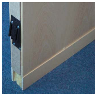
Bild 417-418 erste Prototypenserie der zweischaligen Wandelemente, hier Decken und Bodenanschluss mit patentierten Justierfüßen und Schnellverbindern
