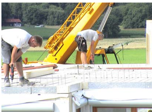
Bild 312 Abschrauben der Deckenelemente
