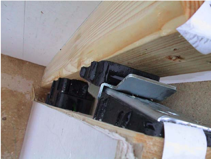
Bild 306 Zum Vergleich: Schwerlastverbinder für den Holzbau, Blick in den Stoßbereich
