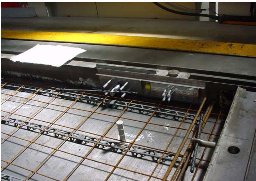
Bild 356 erste Prototypenfertigung im 1:1 Großversuch, Bewehrungsanschluss
