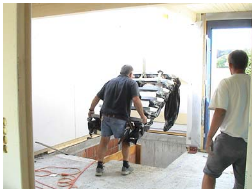
Bild 261 Einsetzen der Fertigterrasse in Aussparungen
