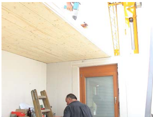
Bild 309 unterseitig fertige Holzdecke
