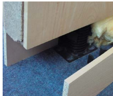
Bild 417-418 erste Prototypenserie der zweischaligen Wandelemente, hier Decken und Bodenanschluss mit patentierten Justierfüßen und Schnellverbindern
