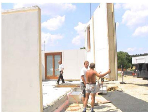
Bild 254 Justieren und Fixieren der Wände
