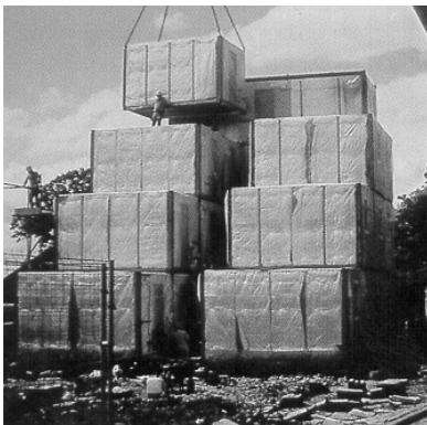
Bild 167 Montage witterungsgeschützter Raumzellen
