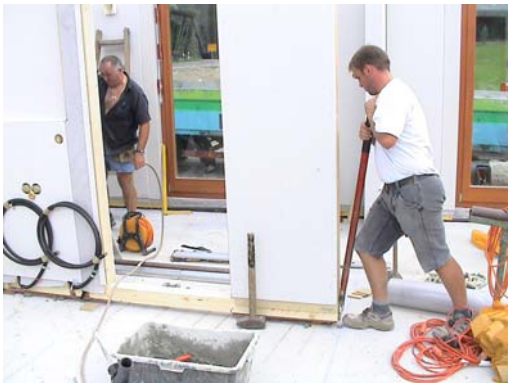
Bild 256 Justieren der Innenwände zueinander
