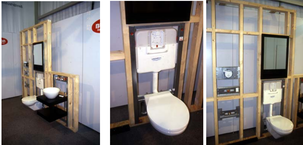
Bild 398 Rohlinge ohne Beplankung Badezimmer Anbaumodul
