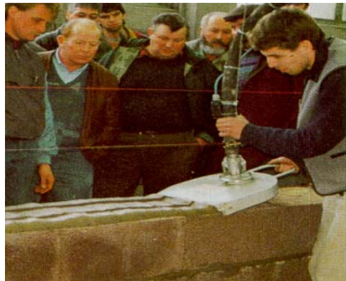
Bild 106 Teilautomatischer Mörtelauftrag Steinherr
