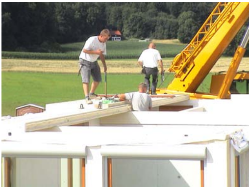
Bild 258 Legen der ersten Deckenelemente Element 1
