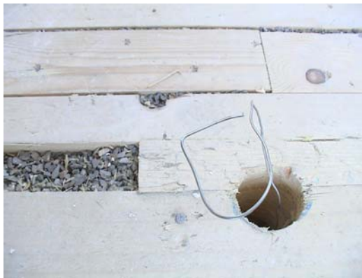
Bild 307 Lignotrenddecke mit Aussparung für Zugdraht Deckenelement
