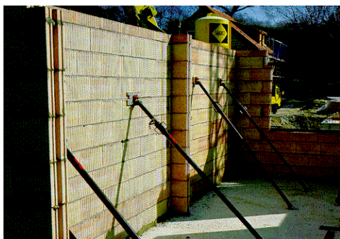
Bild 94-97 Montageverlauf der Mauertafelemente
