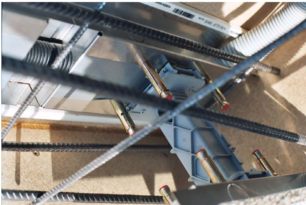
Bild 351 Einsatz herkömmlicher Distanzhalter (Fa. Kaiser) bei Gegenüberlage von Einlegebuchsen
