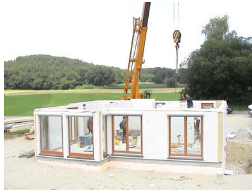
Bild 257 Ausrichten und Fixieren der Innenwände
