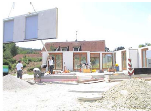
Bild 253 4 Arbeiter werden benötigt für Positionieren
