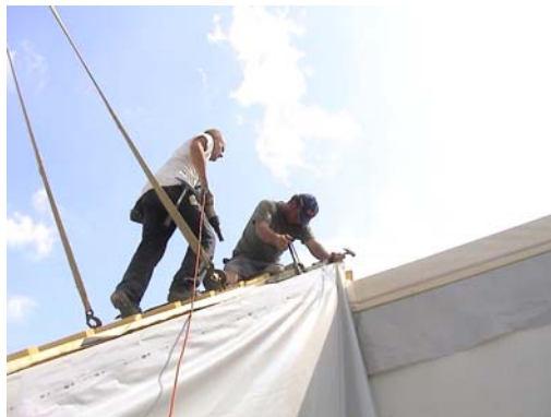
Bild 273 Anpassarbeiten im Firstbereich
