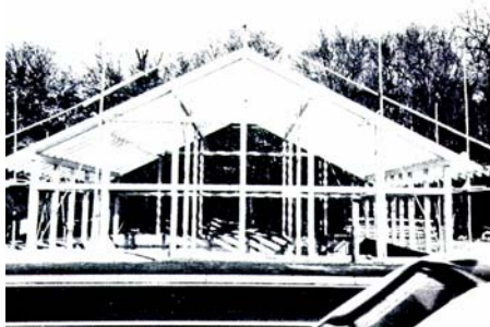
Bild 127 Tragkonstruktion in Skelettbauweise
