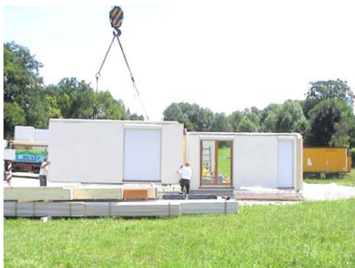
Bild 252 Stellen der ersten Erdgeschosswände
