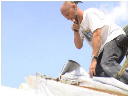
Bild 272 Fixieren der Dachelemente
