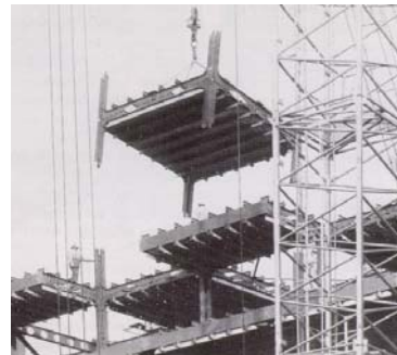
Bild 160 Montage der vormontierten Tragwerkseinheiten
