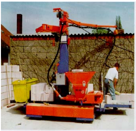
Bild 103 Steinherr Mauermaschine
