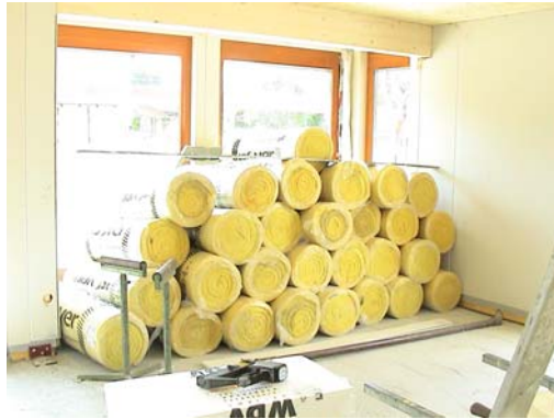
Bild 269 Zwischenlagern der Dachdämmstoffe
