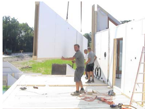
Bild 263 Setzen der Kniestöcke
