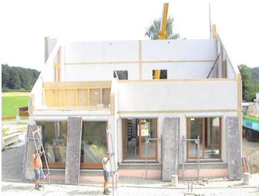
Bild 264 Stellen des Gerüsts zur Dachmontage
