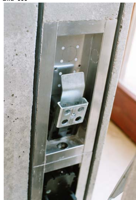
Bild 354 Betonmodelle nach dem Ausschalen, oben rechts: Schwerlastverschraubung und Leerrohreinleitung
