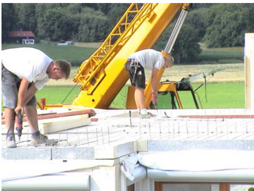
Bild 260 Abschrauben der Deckenelemente
