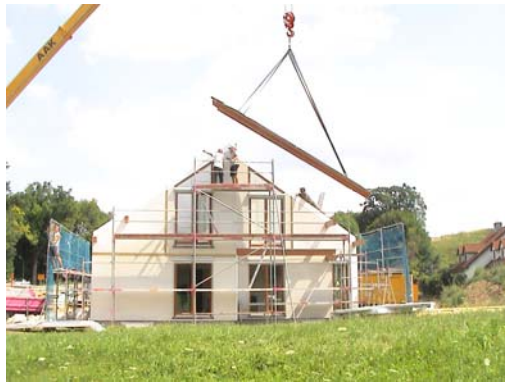
Bild 271 Schließen der Dachfläche
