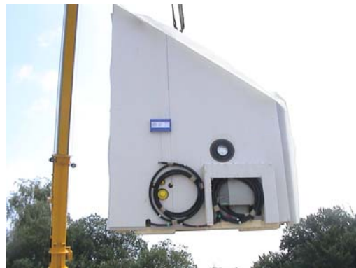
Bild 265 teilinstallierte Giebelelemente
