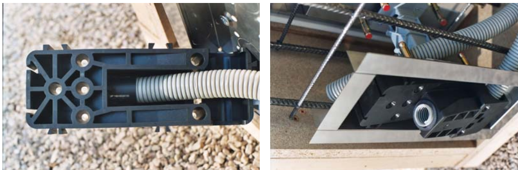
Bild 347 Prototyp der Fixierhilfe in Schnellverbinder eingebaut ermöglicht Leerrohr-System
