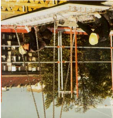
Bild 74 Montage Elementplatte
