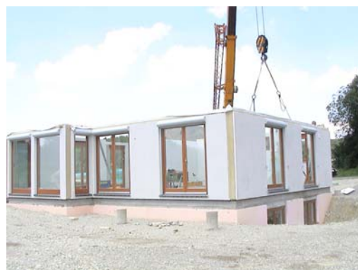
Bild 255 Ausrichten der Erdgeschossaußenwände
