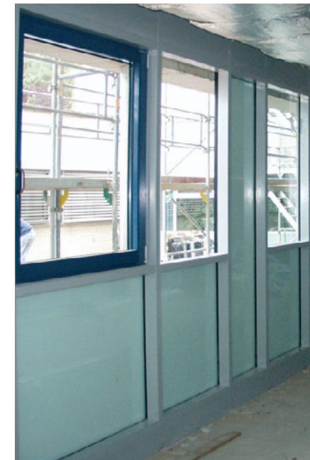
Abb. 4.12 Innenansicht VIP-Fassade eines Krankenhauses in Erlenbach (ZAE). 22
