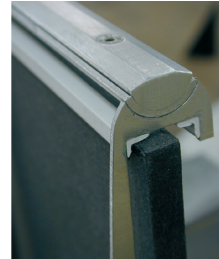
Abb. 7.32 Detail der Membran-Klemmung. Die Kunststoff-L-Winkel, die neben dem Halbrohr die einzelnen Rippen verbinden und das VIP auf Abstand halten und dadurch schützen, sind ebenfalls zu sehen.
