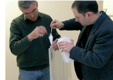
Abb. 7.55 Füllung der einzelnen Lamellenkammern mit Aerogelgranulat der Firma Cabot.
