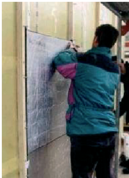
Abb. 4.34 ...während der Montage.
