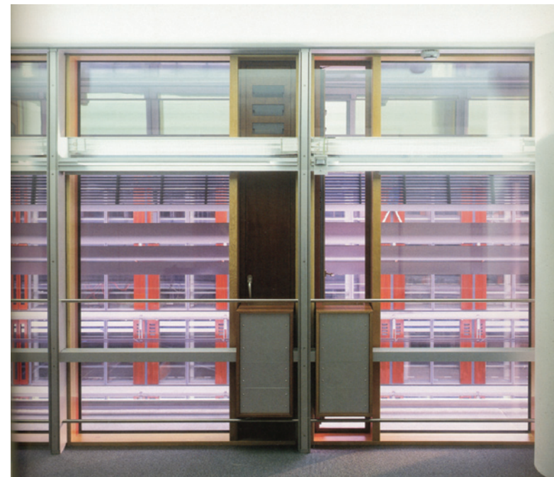
Abb. 4.48 (oben) und Abb. 4.49 Plan (o. M.) und Innenansicht zeigen die in die Fassade integrierten Lüftungsklappen der ZVK Wiesbaden von Herzog+Partner. In der Zeichnung sind dazu zwei Horizontalschnitte dargestellt, einmal durch den ungestörten Regelquerschnitt (links, hier wäre auch der Einsatz von VIP gut vorstellbar), zum anderen durch die zusätzlichen Kunststoff-Lufteinlässe.
