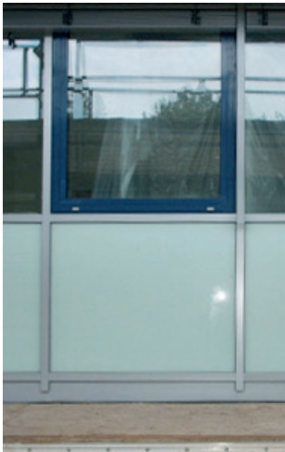
Abb. 4.13 Außenansicht VIP-Fassade eines Krankenhauses in Erlenbach (ZAE).
