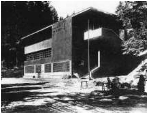
Abb.217 Schalterhalle Abb.218 Ansicht der Rückfassade
