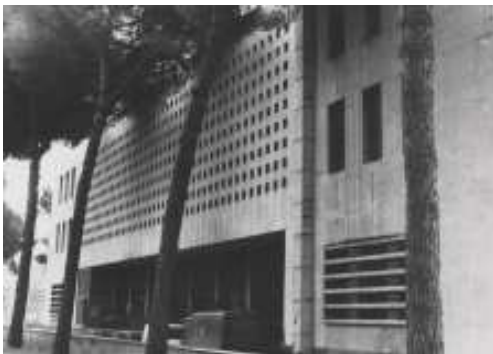
Abb.87 Blick vom Telegrafensaal auf die Hauptfassade
