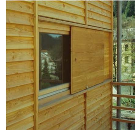
Abb. 3.02 Lichtundurchlässige Komponente: Schiebeläden (Altenwohnheim, Neuenbürg D; Arch.: Mahler Günster Fuchs)
