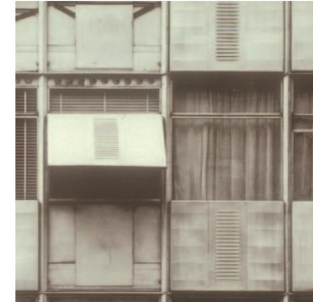
Abb. 3.14 Ausklappbarer vertikal verschieblicher Laden (Square Mozart, Paris - Arch.: Jean Prouvé)
