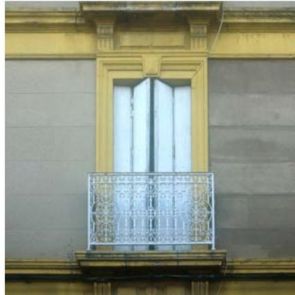
Abb. 1.06 (nahezu) geschlossene Faltschirme: Eintritt von Tageslicht durch vertikalen Spalt: hoher Leuchtdichtekontrast im Innenraum - typische Situation im Mittelmeerraum / Südeuropa (Ollioules, Provence F)
