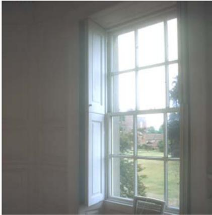
Abb. 3.07 Vertikalschiebefenster mit innenliegendem Fallladen, der gleichzeitig die Revisionsklappe für die Gewichtsführung verdeckt (Melford House, Sudbury UK)
