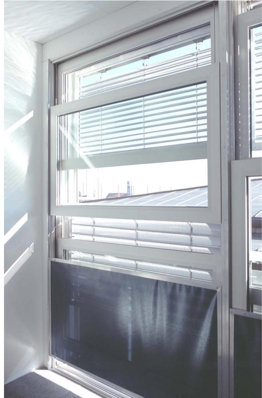
Abb. 7.29 Einfluß des mehrschichtigen Fassadenaufbaus mit vertikal verschieblichen Komponenten auf den Innenraum (freie Kombination)
