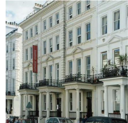
Abb. 3.03 Fassadefront mit Vertikalschiebefenstern, London UK
