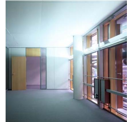
Abb. 1.07 Verschattungselemente mit horizontaler Öffnung oberhalb der Augenhöhe mit Lichtlenkelementen für Eintritt von Tageslicht: gute Lichtverteilung im Innenraum (ZVK, Wiesbaden; Arch.: Herzog + Partner; Photo: Robertino Nikolic / artur)
