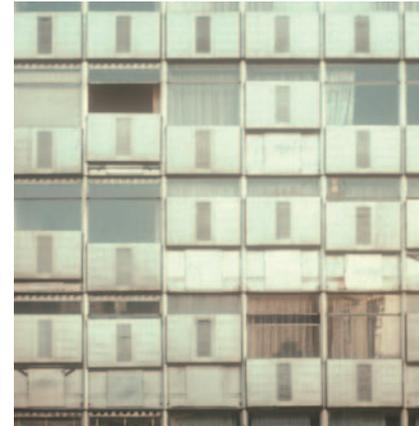
Abb. 3.13 Fassade mit vertikal verschieblichen Elementen, Square Mozart, Paris - Arch.: Jean Prouvé
