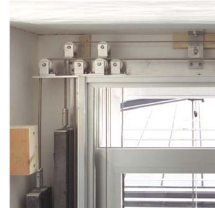
Abb. 7.18 Aufhängung der Bleigewichte und versetzt angeordnete Rollenpaare zur Führung der Edelstahlseile im Sturzbereich (seitliche und obere Abdeckung entfernt)
