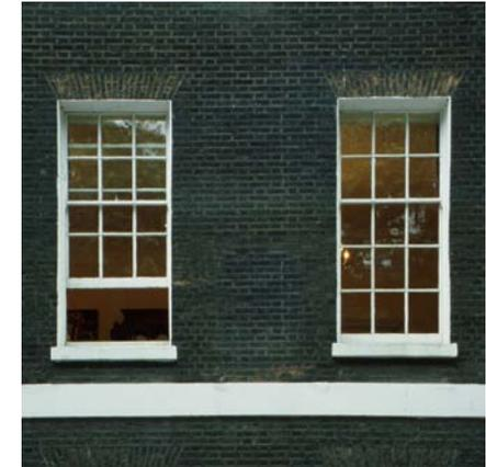
Abb. 3.06 Vertikalschiebefenster, London UK
