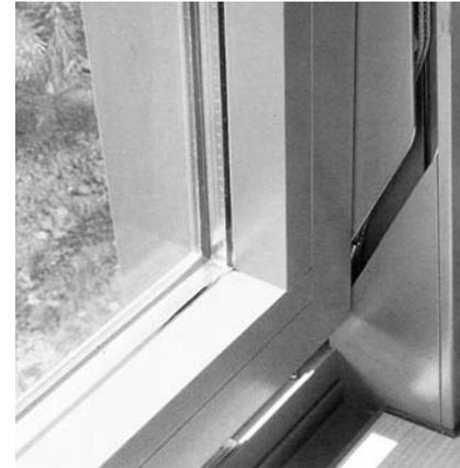
Abb. 4.06 Beispiel für versetzte Führungsnut + versteckte Seilführung, Material der Fassadenkonstruktion: Aluminium (Fa. Hartmann, CH)
