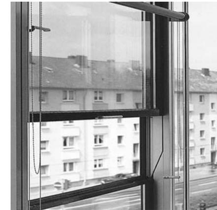
Abb. 3.12 Zweiflügeliges Vertikalschiebefenster mit gekoppelten Flügeln in geöffnetem Zustand (Fa. SCHÜCO)
