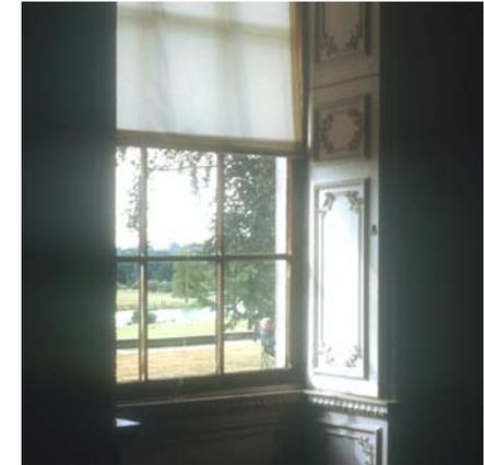
Abb. 2.07 Vertikalschiebefenster: Kombination mit innenliegendem Manipulator (Claydon House, Claydon UK)
