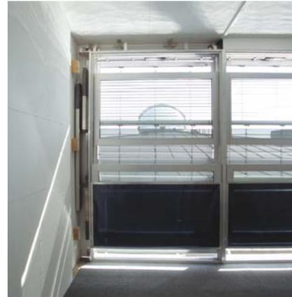
Abb. 7.17 Anordnung der Gegengewichte und Seilführung für die Flügel (seitliche und obere Abdeckung für linkes Fassadenfeld entfernt)
