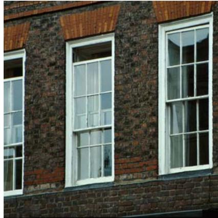
Abb. 3.05 Vertikalschiebefenster, Cambridge UK
