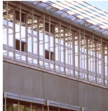
Abb. 3.09 Vertikalschiebefenster in Pfosten-Riegel-Fassade, Erweiterung Berufsschule, Heilbronn-Böckingen D (Fa. Gartner)
