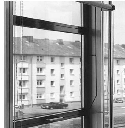
Abb. 3.11 Zweiflügeliges Vertikalschiebefenster mit gekoppelten Flügeln in geschlossenem Zustand (Fa. SCHÜCO)
