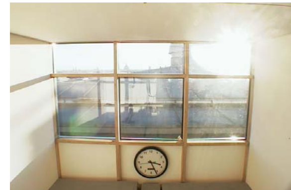
Abb. 5-47: Blendeffekt durch die tiefstehende Wintersonne nach der Aufklärung der vertikalen TTV durch einen vorübergehenden Schattenwurf, 05.12.00, 15:25, Situation 2.
