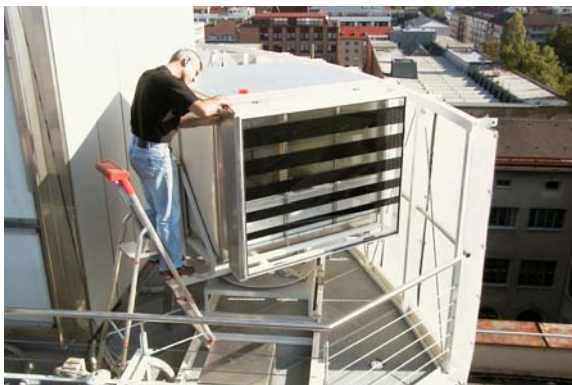
Abb. 6-9: Montage der zweiten Fassadenebene am maßstäblichen Versuchsraum.
