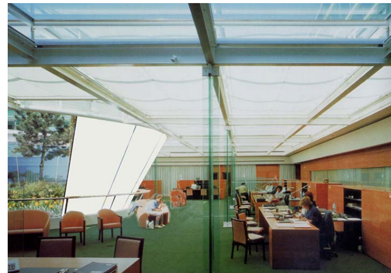
Abb. 7-7: Foyer der Städtischen Verwaltung in Saint-Germain-en-Laye im ausgeführten Zustand (oben) und mit einer eingetrübten TTV zum Innenhof (Bildmontage, unten). (S. 54, [SCHIT98])
