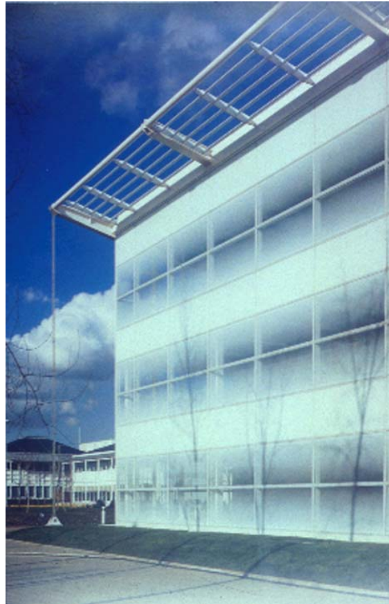
Abb. 6-7: Bürogebäude Stockley Park B3 (Architekt Sir Norman Foster, 1989) mit einem weiß emaillierten, verlaufenden Punktraster als Sonnen- und Sichtschutz. (S. 108, [ARC89])
