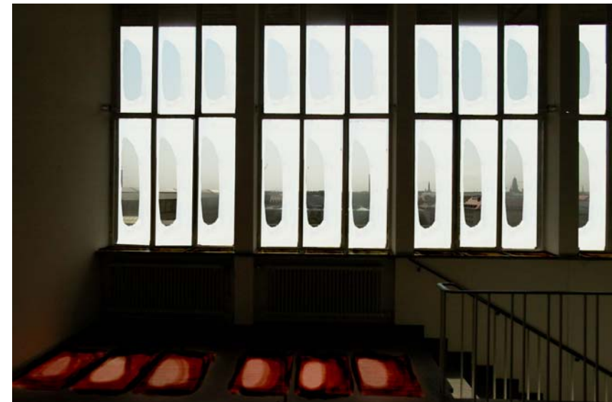
Abb. 7-1: Ostfassade vom Süd-Treppenhaus des Hauptgebäudes der TU München im 5. Stock mit unterschiedlich eingetrübter TTV (Bildmontage).
