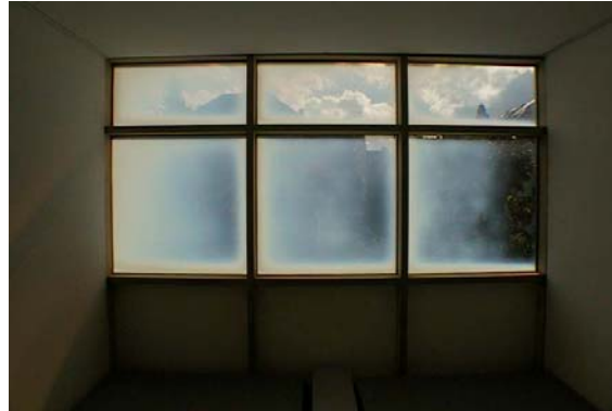
Abb. 5-44: Aufklarende TTV in der vertikalen Verglasung weist Ähnlichkeiten mit sich lichtendem Nebel auf und ist ungewöhnlich bei nahe liegenden Gebäuden, 02.11.99 um 13:12, Situation 1.
