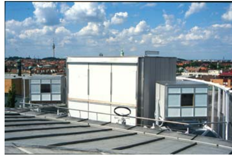
Abb. 5-17: Gesamtansicht der Solarstation mit den drei Versuchsräumen während der Referenzmessung mit Streuglas (links), sowie dem maßstäblichen Versuchraum mit transluzenter TTV teillächig im Fensterbereich (mitte) und analog eingebautem Streuglas (rechts).
