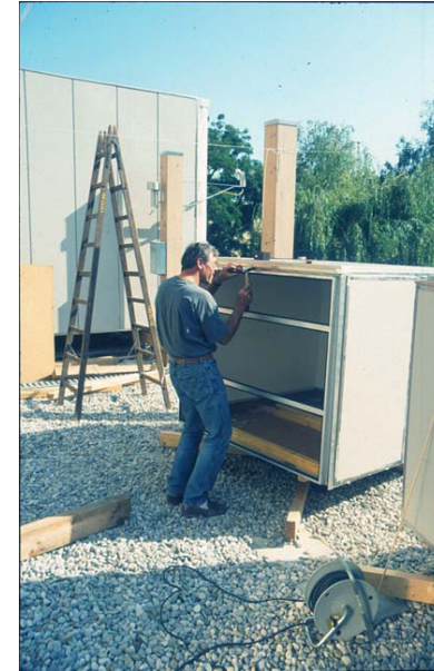
Abb. 4-5: Zusammenbau der Versuchsräume im Maßstab 1:2.5
