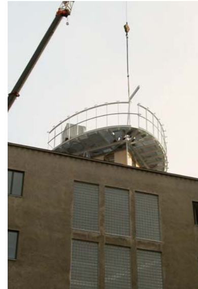
Abb. 4-9: Montage der „Station für Solarforschung“ mit den Versuchseinrichtungen
