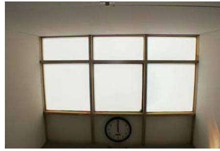
Abb. 5-7: TTV vollflächig im Fenster- und Überkopfbereich mit opaker Brüstung: Raumsituation (links) und horizontale Beleuchtungsstärkeverteilung in Arbeitshöhe (mitte) im Testraum sowie Tageslichtquotient in der mittleren Raumachse von Test- (rot) und Referenzraum (Klarglas, blau) im Vergleich (rechts) beim Eintrübungsvorgang vom 26.09.2000 um 11:15, 11:30, 11:45 und 12:00 (von oben nach unten, Situation 2). Horizontale Außenbeleuchtungsstärken: 53918, 63662, 73100 bzw. 83068 lx, Orientierung 24° SSW.
