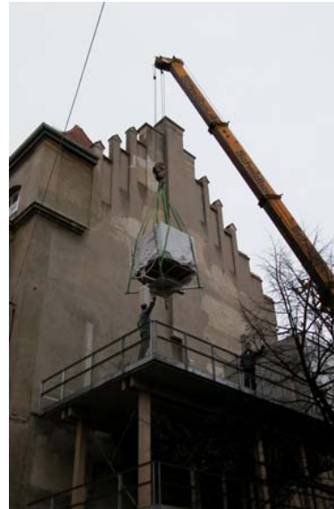
Abb. 4-8: Abbau der Versuchseinrichtungen am ehemaligen Forschungsgerüst
