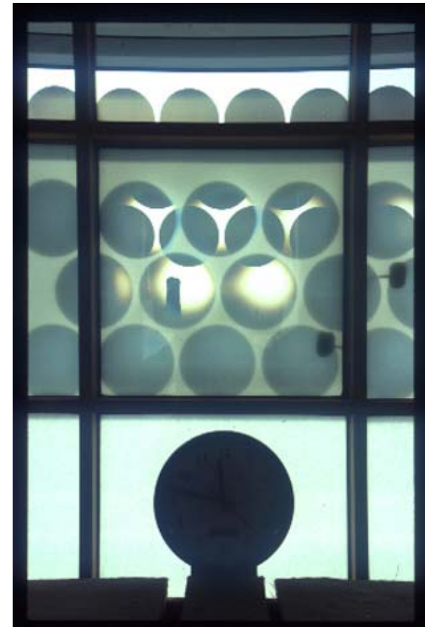
Abb. 6-20: Detailansicht bei der Überlagerung von ausfliegender Bedruckung, auf transparentem Glas und innenliegender, teilweise eingetrübter TTV. Im Hintergrund ist die Münchner Frauenkirche zu erkennen.
