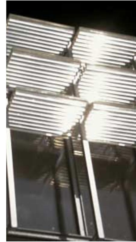
Abb. 5.17: Außenansicht, Lichtumlenkung außen bei horizontal ausgerichteter Lamelle und Einstrahlung außerhalb des Akzeptanzbereiches.
