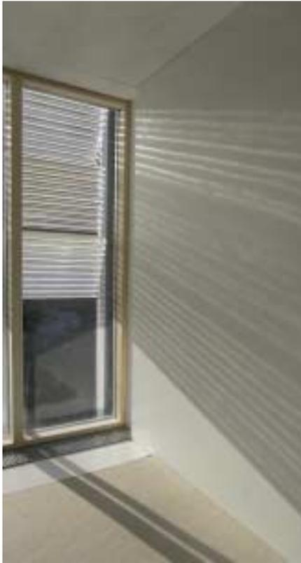
Abb. 5.14: Innenansicht, Sonnenschutz bei Einstrahlung im Akzeptanzbereich. Die Streifenbildung entsteht durch Licht, das durch die Abstandsflächen zwischen den CPC-Profilen transmittiert wird.
