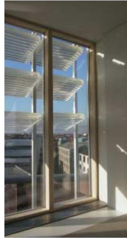
Abb. 5.16: Innenansicht, Sonnenschutz bei leicht geneigten Lamellen und Einfallsrichtung außerhalb des Akzeptanzbereiches. Die Direktstrahlung wird durch die Lamelle transmittiert und umgelenkt (s. Abb. 5.17)
