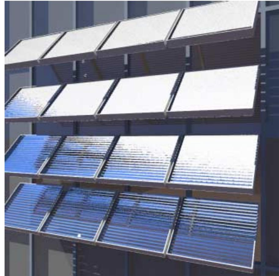
Abb. 3.55: Außenwirkung eines 25°/42°-CPC-Sonnenschutzes mit opaken Zwischenflächen bei direkter Besonnung
