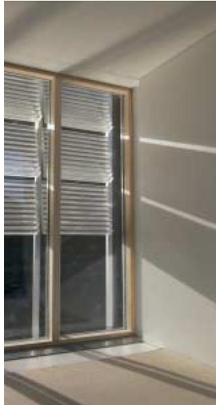
Abb. 5.15: Innenansicht, Lichtumlenkung an die Decke bei leicht nach außen geneigter Lamellenstellung und flachem Einfallswinkel außerhalb des Akzeptanzbereiches
