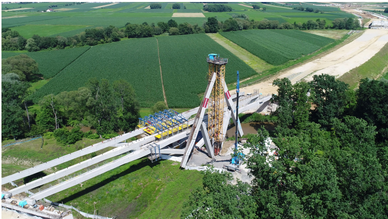
Abb.1: Letzter Klappvorgang bei der Brücke über die Lafnitz (Foto: TU Wien)
