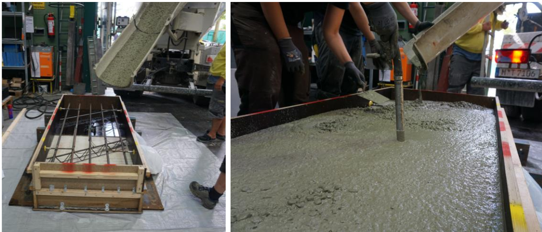
Abbildung B-9: Einbau des Betons in den Probekörpers (links), Verdichtung des Betons mit Rüttelflasche (rechts)
