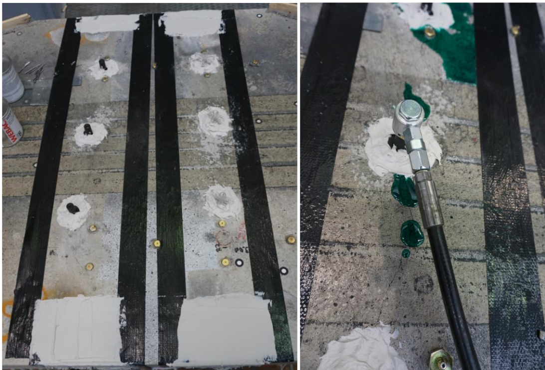
Abbildung B-19: Angebrachte Packer an Oberfläche (links), Verpressung der Risse (rechts)
