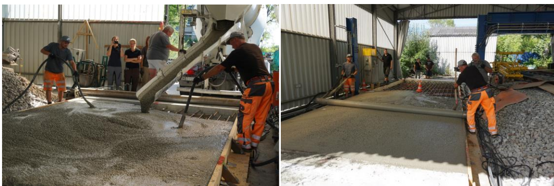
Abbildung B-3: Einbau des Betons (links), Herstellung der Betonoberfläche mit Nivellierwalze (rechts)
