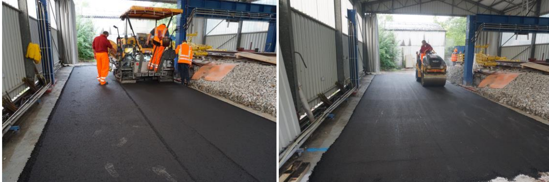
Abbildung B-1: Asphaltteinbau – Straßenfertiger (links), Tandemwalze (rechts)
