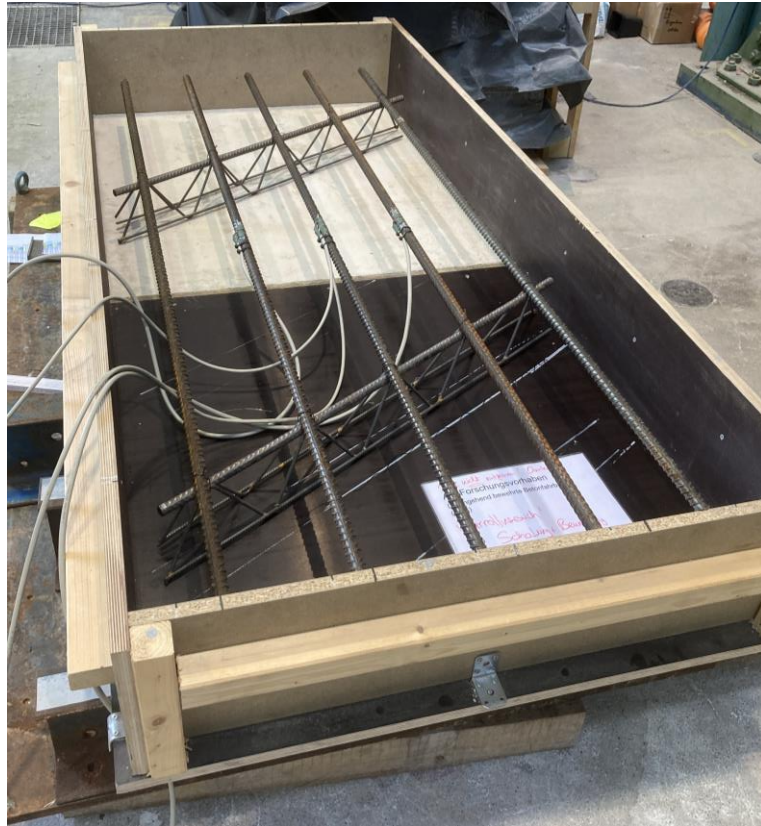
Abbildung B-8: Schalung mit verlegter Bewehrung und integrierter Messtechnik
