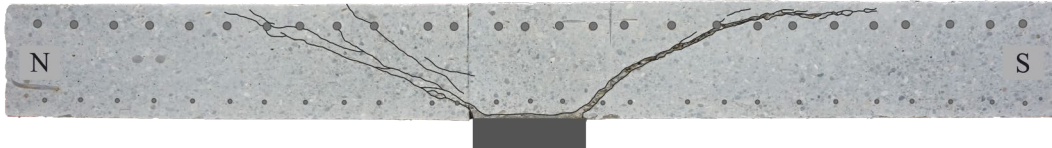
Bild A.101: Rissbilder der Trennschnitte 1 und 2 des Versuchskörpers M1-30-1.23
