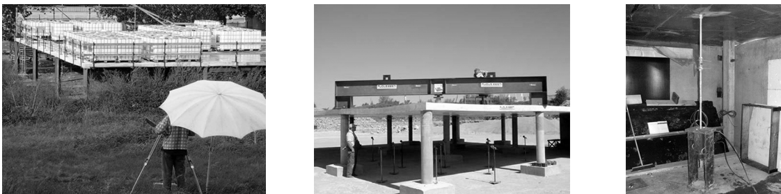
Bild 3.6: Durchstanzversuche an rein stahlfaserbewehrten Flachdeckensystemen von GOSSLA [97] (links), DESTREE / MANDL (Mitte) [50], HEDEBRATT / SILFWERBRAND (rechts) [119], entnommen aus [50, 97, 119]
