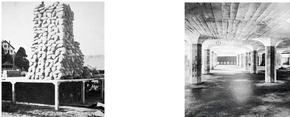
Bild 3.1: Belastungsversuch einer unterzugslosen Pilzdecke 1908 (links); Ausgeführte Pilzdecke in einem Lagerhaus in Zürich-Giesshübel 1910 (rechts), beide entnommen aus [224]
