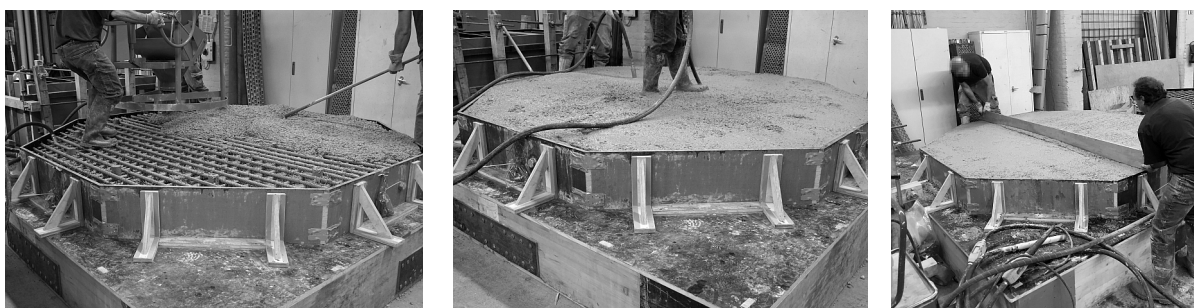
Bild 4.13: Betonage, Verdichtung und Abziehen der Versuchskörper
