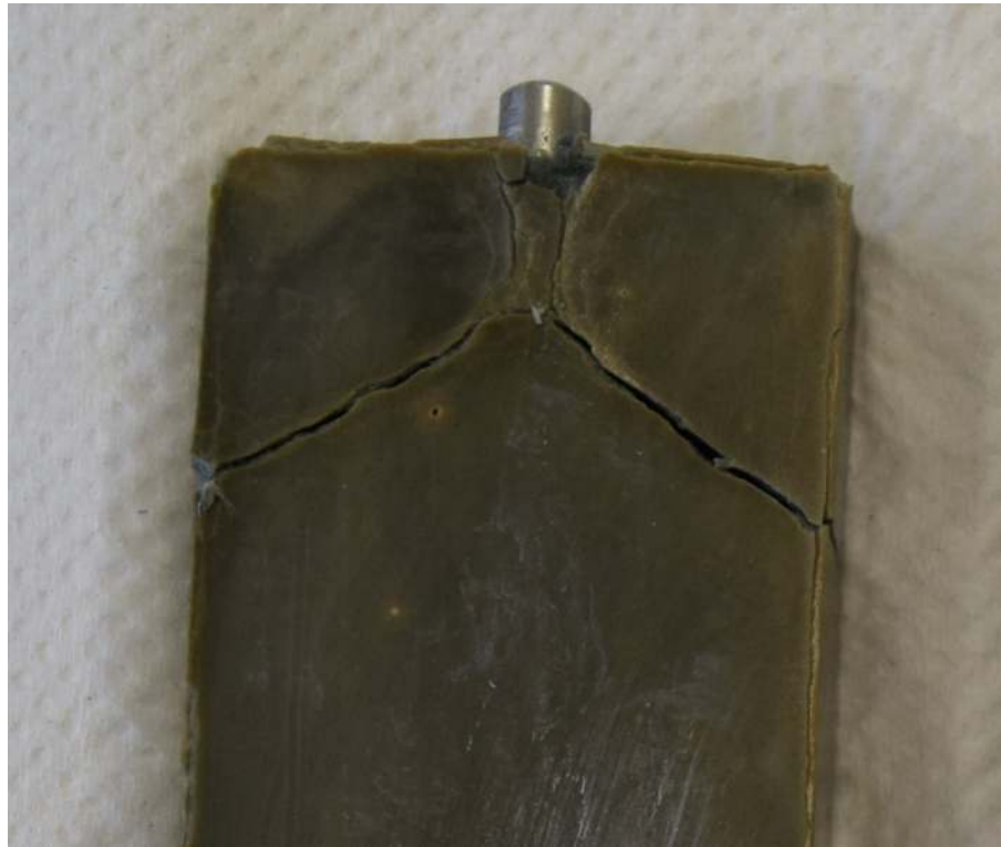
Abbildung 16 Typisches Rissbild im Bereich der Messzapfen von Zementsteinflachprismen nach Lagerung in einer Natriumsulfatlösung ( 30 \text{ g l}^{-1} \text{ SO}_4^{2-} ). Abgebildete Probe: 36_GGBS, Lagerungsdauer 77 d. Breite der Prismenstirnseite: 40 mm.
