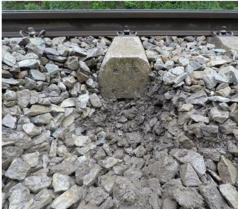
Abbildung 34: In den meisten Fällen sind Schotterverschmutzungen nicht von außen zu erkennen. (Aufnahme: Verfasser am 28.05.2019)
