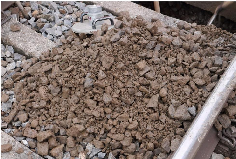
Abbildung 44: Ausgebauter und verschmutzter Schotter (Aufnahme: Verfasser am 02.03.2020)
