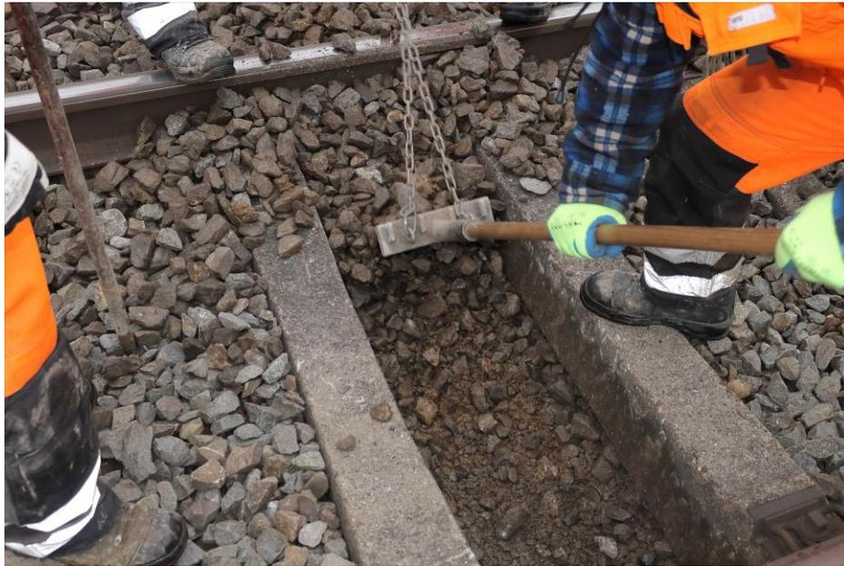
Abbildung A. 22: Auskoffern des Schwellenfaches (Aufnahme: Verfasser am 02.03.2020)
