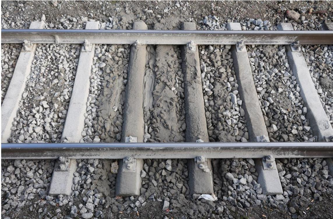
Abbildung 33: Das Endstadium einer Schlammstelle zeichnet sich durch das Auspressen von Schlamm an der Bettungskrone aus. (Aufnahme: Verfasser am 10.01.2020)
