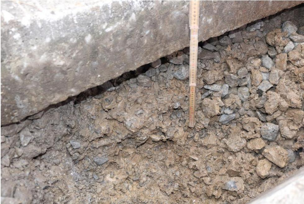
Abbildung 43: Schotter mit bräunlichen Verschmutzungen ab ca. 0,15 m unter Schwellenunterseite (Aufnahme: Verfasser am 02.03.2020)
