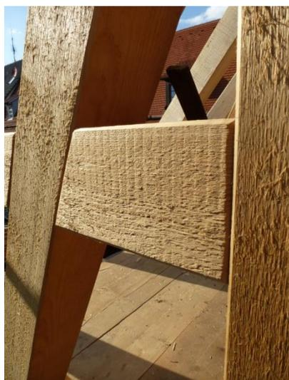
Abb. 67 Dachkonstruktion, Holzbalken, Gattersägespuren
