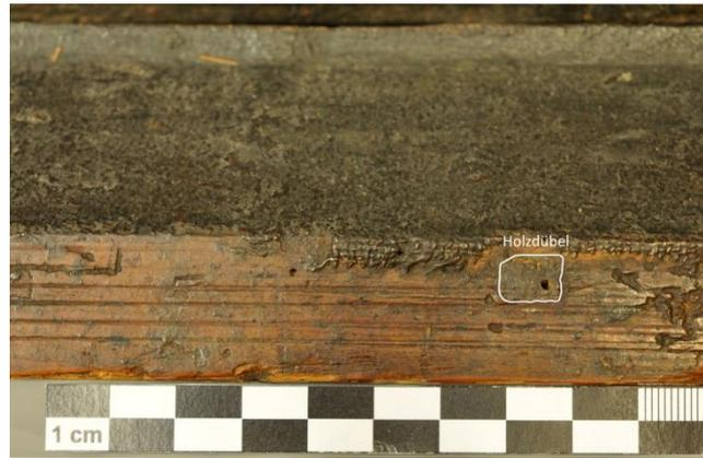
Abb. 49 Wasserschlagleiste, Holzdübel, Gewebekaschierung
