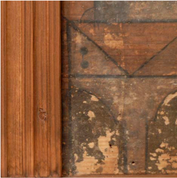
Abb. 144: Die Malerei reicht nicht vollständig bis an die erneuerten Pilaster heran, Frontdetail, Truhe 13.
