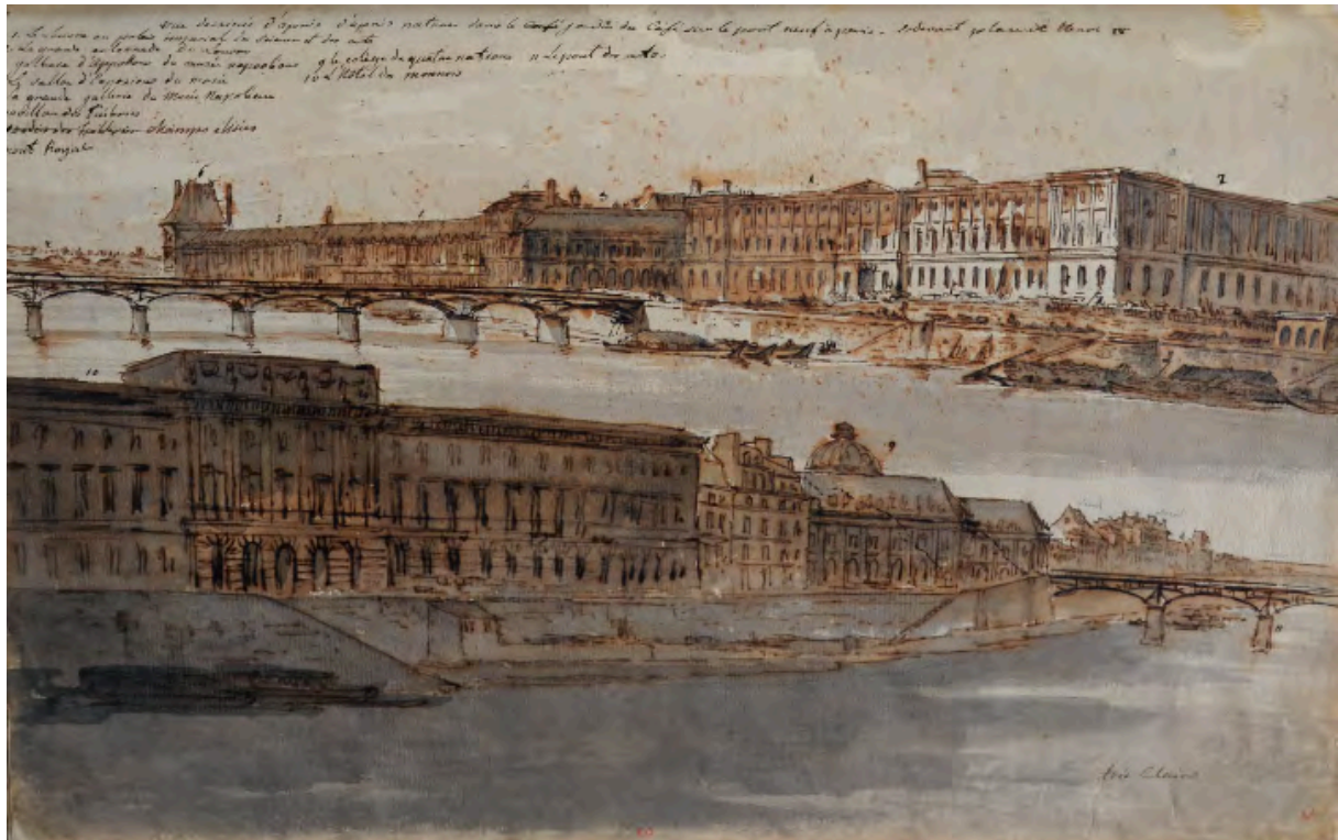
Abb. 9: Carl von Fischer, Skizzenbuch Frankreich, Italien, 1806-08, Kat. 1: folio 2 recto: zwei Perspektiven als lasierte Federzeichnungen der Tuileries an der Seine, bezifferte Gebäude und Legende »Vue dessinée d'après nature dans le jardin du Café sur le pont neuf à Paris. Devant place Henri IV«.
