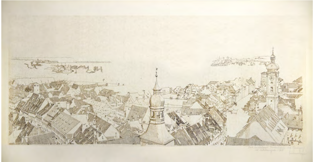
folio 6: Teilstück Altes Rathaus mit Hl. Geist des Panoramas von München »Nach der photograph. Rundaufnahme vom Petersturm im Jubiläumsjahr 1858 Leitenstorfer«;
