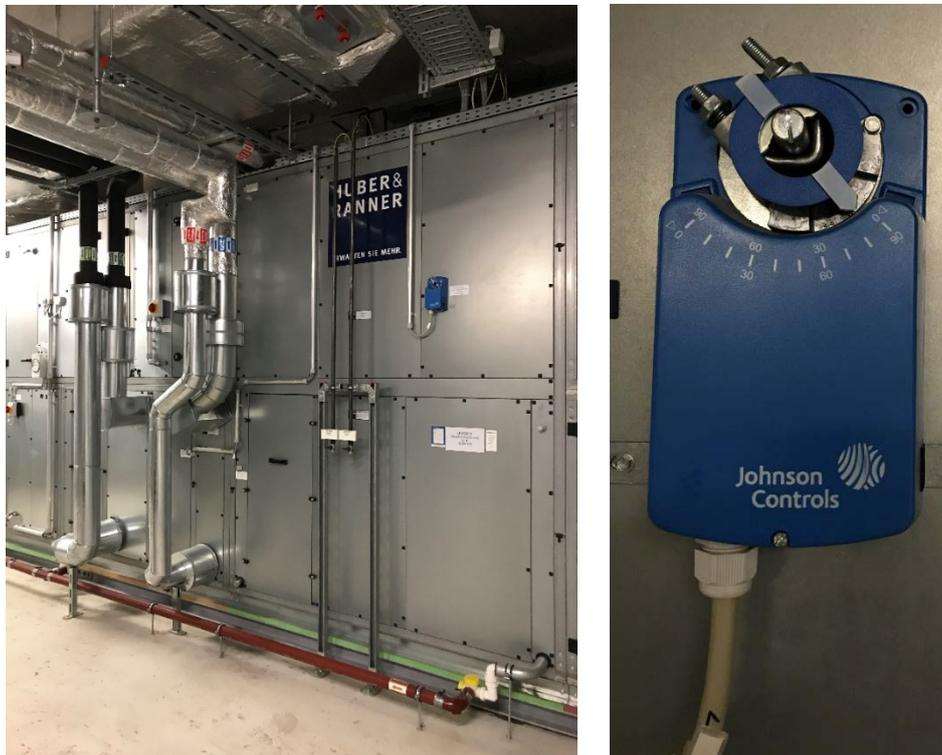
Abbildung 28: Untersuchte RLT-Anlage und defekte Bypassklappen-Steuerung
