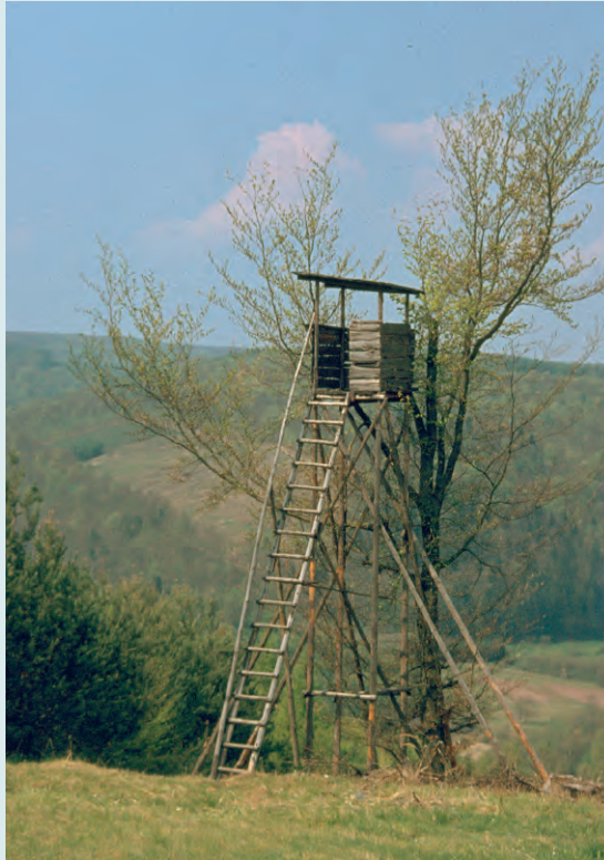
Hochsitze und Kanzeln jetzt kontrollieren und die Kontrolle unbedingt dokumentieren (Foto: H. Blesch)
