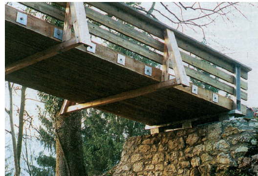
(b) fertiges Brückenbauwerk
