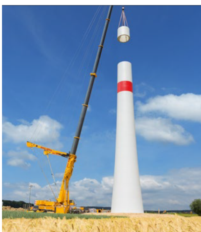
(a) Montage der Turmsegmente
