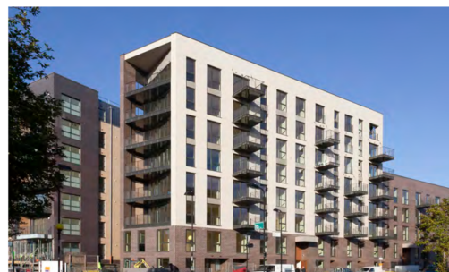
(b) Außenansicht des fertigen Gebäudes
