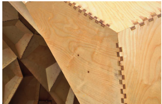
Abbildung 5.3: Herstellung von individuellen Verzahnungsgeometrien mit einem Ab- bündroboter, Detail einer Bauteilfuge [Knippers et al. 2012]
