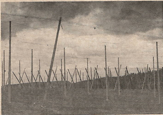
Hopfengerüst mit Stahlbetonmasten Foto: Kamm
