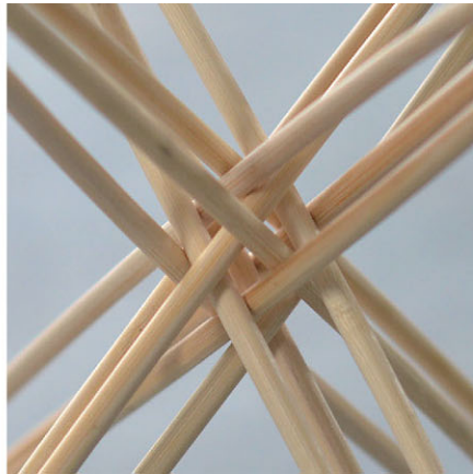
Bild 6 Geflochtener Knotenpunkt des Scherenmoduls Braided scissor joint
