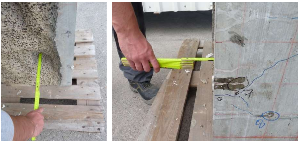
Abb. 7-20: Abplatzungen nach der Brandprüfung Q-ZTV-90-0PP.
