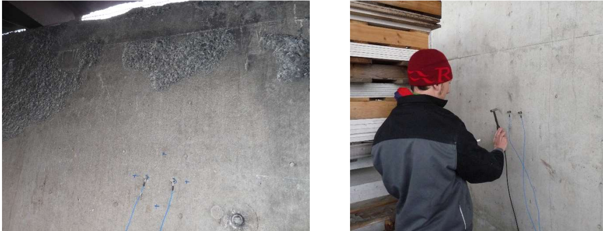
Abb. 3-18: Untersuchungen mit der Impakt-Echo-Methode an der durch Brand geschädigten Wand nach dem Experiment am Brückenbrandprüfstand.
