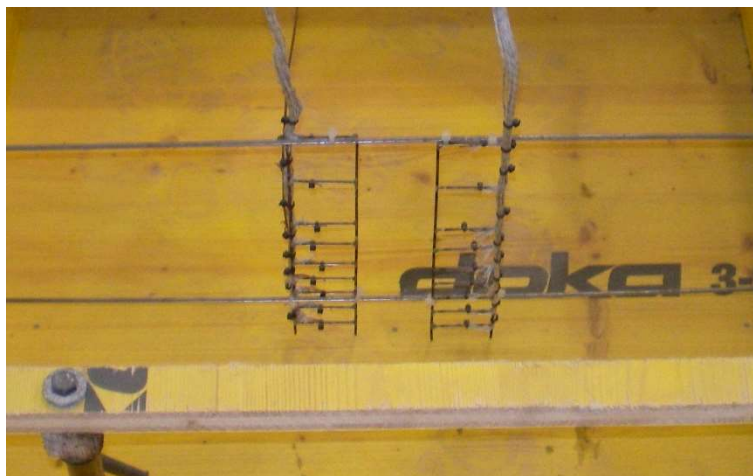
Abb. 7-1: In der Schalung angeordnete Leitern mit Temperturmessstellen in verschiedenen Tiefen.
