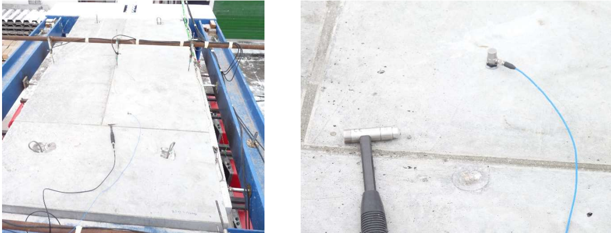
Abb. 3-17: Impakt-Echo Messungen während des Brandexperimentes P-HC+K-65-1,5PP_IE.
