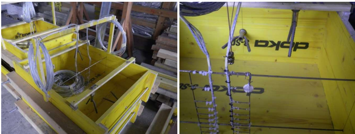
Abb. 11-13: Befestigung der Ultraschallgeber in der Schalung vor dem Betonieren.
