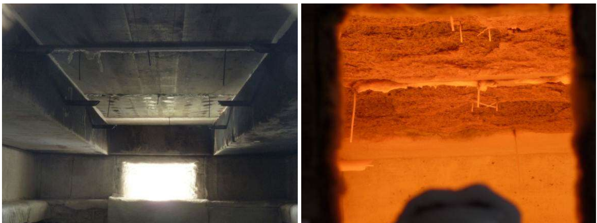
Abb. 5-5: Blick durch das Beobachtungsfenster in den großen Tunnelofen der MFPA Leipzig GmbH, links vor dem Experiment, mit intakter Betonoberfläche und rechts während des Experimentes, mit eingeschalteten Ölbrennern. Gut sichtbar sind die Schädigungen durch Abplatzungen.
