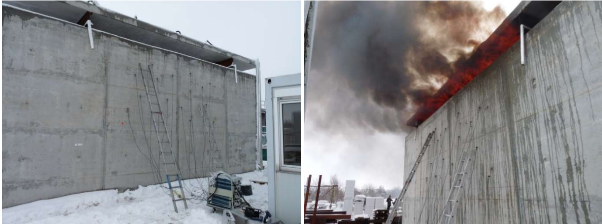
Abb. 5-14: Auf der Rückseite der Wand wurden Schallemissionssensoren installiert, um die Schädigung der Wand zu erfassen.
