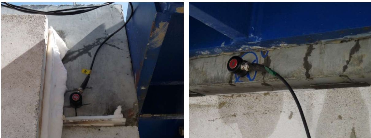
Abb. 6-6: An den Seiten der Testkörper angebrachte Schallemissionssensoren.
