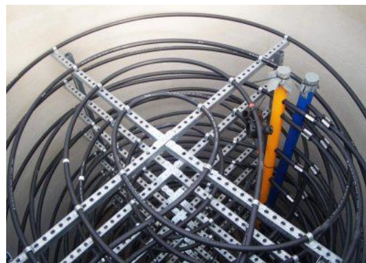
Abb. 2.30: Anlagenschema und Wärmeübertrager des Wärmequellenspeichers, Quelle: Viessmann Deutschland GmbH.
