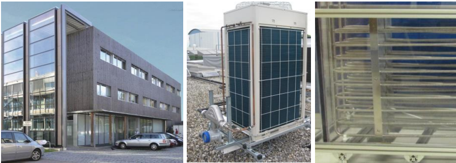
Abb. 6.1: Bilder des Forschungsprojekts: Institutsgebäude, auf dem Dach aufgestellte Außeneinheit des VRF-Systems und Ausschnitt des noch nicht gefüllten Latentwärmespeichers, Quelle: ZAE Bayern.
