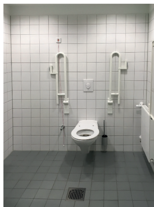
8 Anordnung WC mit Stützklappgriffen
