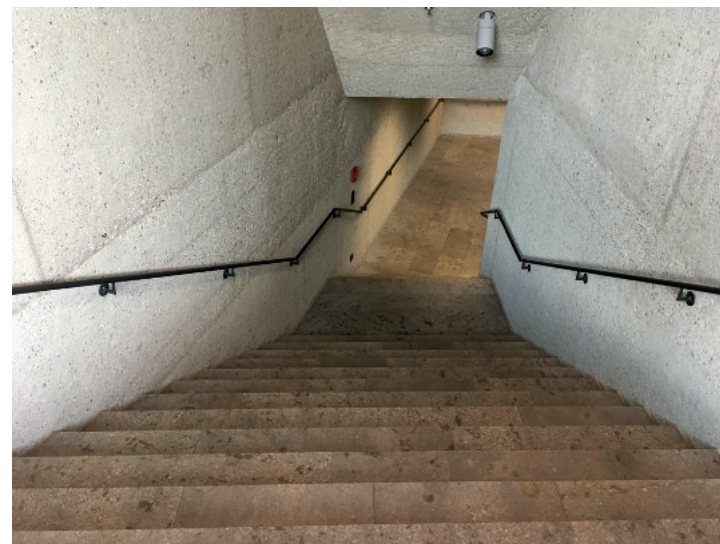
3 Treppe ins UG zu den WC-Anlagen
