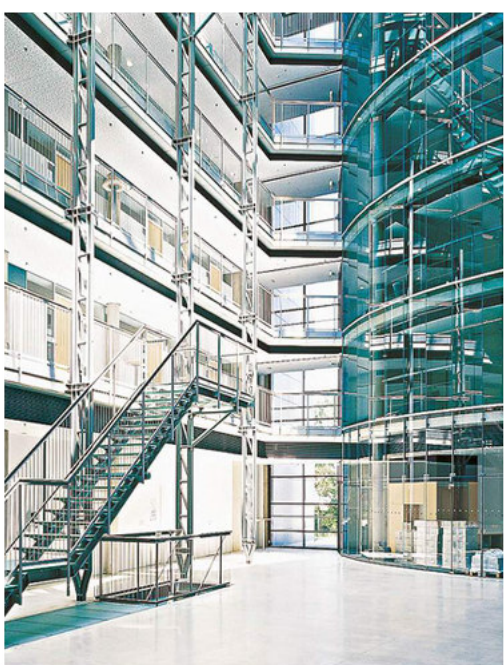
3 | HAUPTHALLE MIT TURM
