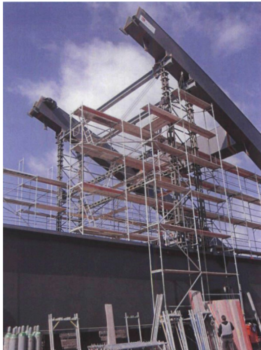
Abbildung 4.4 : Referenzobjekt EÜ über die Mulde: Montage auf dem Vorbauplatz (2)
