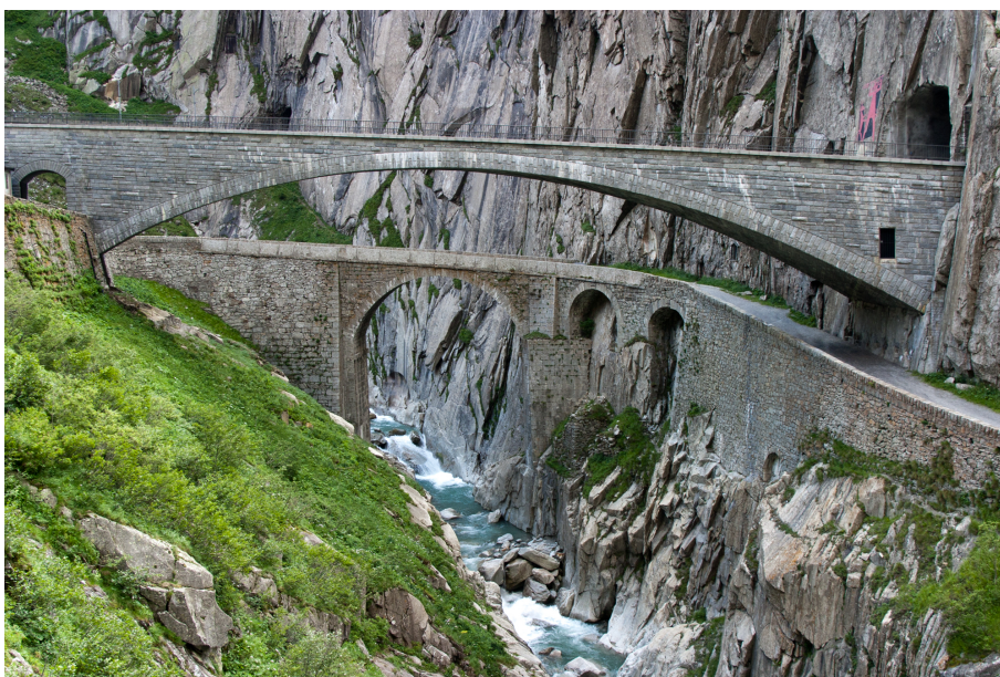
Abbildung 2.1 : Zweite und dritte Teufelsbrücke in der Schöllenschlucht (59)
