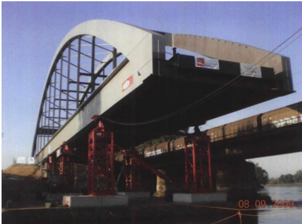
Abbildung 4.5 : Referenzobjekt EÜ über die Mulde: Einschub (2)
