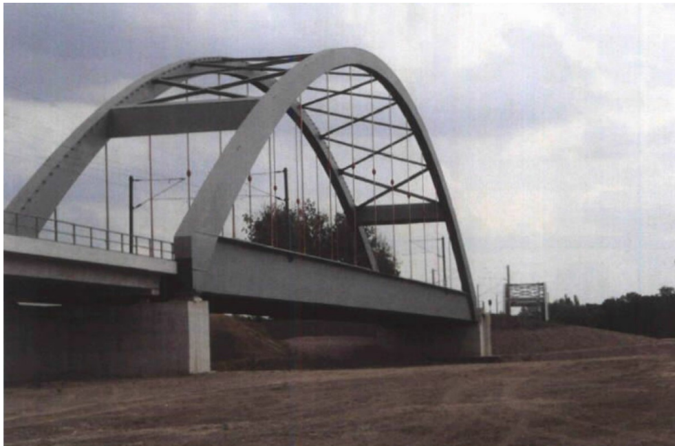
Abbildung 4.6 : Referenzobjekt EÜ über die Mulde: Endlage (2)
