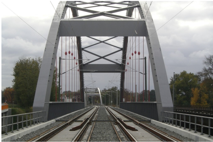
Abbildung 4.1 : Referenzobjekt EÜ über die Mulde: Ansicht mit Blick in globale x-Richtung (2)
