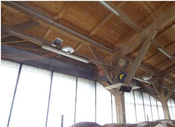
Abb. 36: Video- und Infrarotkameras
