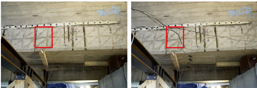
Abb. 5 : Brückenträger vor (links) und nach (rechts) dem Belastungsversuch; der Untersuchungsbereich ist rot markiert.
