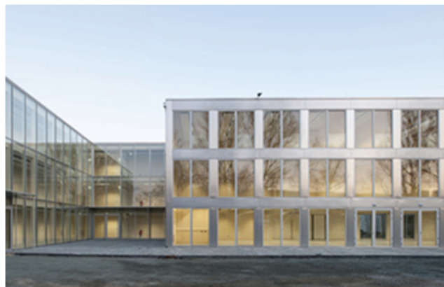
Abbildung 46: Europäische Schule Frankfurt nach der Fertigstellung. Vor Ort wurde die Verglasung in die bereits in der Fertigung versetzten Rahmen montiert und die Fassade verkleidet. Bild: NKBAK Architekten, Fotograf: RADON photography – Norman Radon. Quelle: Geier et al. 2017c, S. 52–55.
