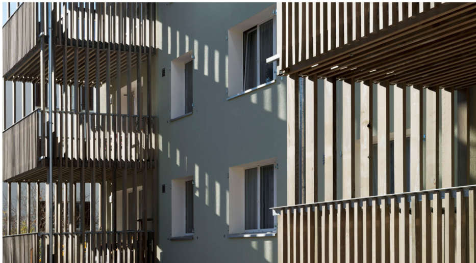
Abbildung 36: Buchenholz-Balkonstruktion am MFH Saumackerstrasse in Zürich. Die konstruktiven Teile sind flexibel gefügt, um die Bewegung des Buchenholzes aufzunehmen. Der Vorgang in der Verfertigung erforderte neue Herangehensweisen in der Sägerei, beim Abbund und im Imprägnierwerk. Bild: kämpfen für architektur ag.
