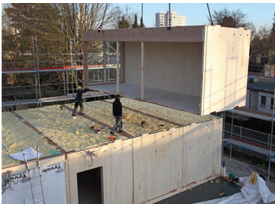
Abbildung 45: Versetzen der Raummodule in der Europäische Schule Frankfurt. Die vorgefertigten Raummodule werden auf der Baustelle versetzt, die Innenoberflächen sind bereits fertig. Bild: NKBAK Architekten. Quelle: Geier et al. 2017c, S. 52–55.
