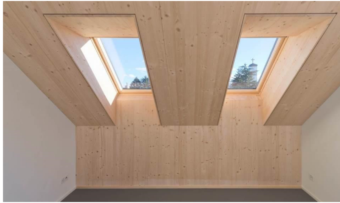
Abbildung 44: Fertige Aufstockung im leanWOOD-Fallbeispiel MFH Saumackerstrasse: Die Innenoberflächen werden bereits fertig geliefert und müssen nicht mehr auf der Baustelle verkleidet werden.
