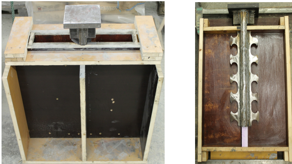
Abbildung 3.2: Stehende Schalung (links) und liegende Schalung (rechts) für Push-Out Körper
