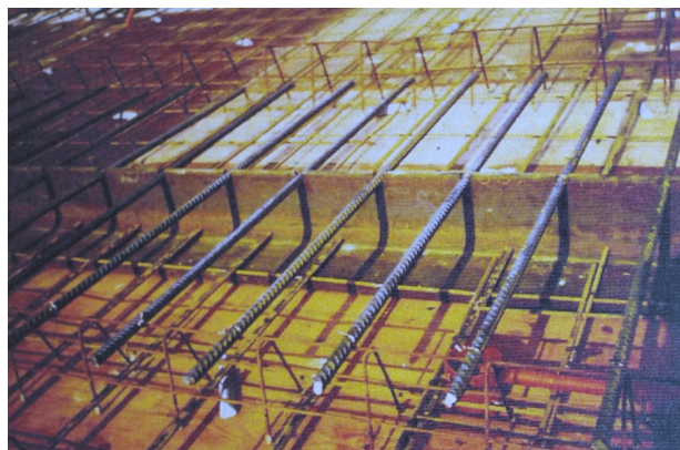
Abbildung 2.15: Erste Anwendung der Kombidübel im Privathaus von Irmfried Brendel [Bre11]
