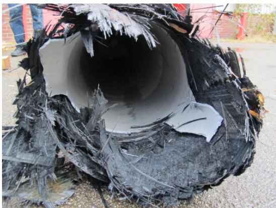
(a) Zylinder des geborstenen Druckspeichers.
