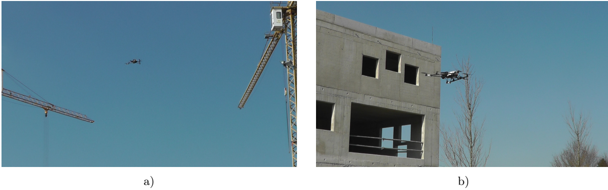
Abbildung 5.7: UAV-Erfassung, a) Kranstellung, b) UAV vor Gebäude bei Schrägsichtaufnahme
