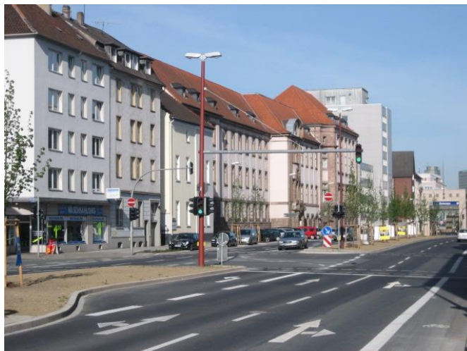
Figure 7.1 Intersection Hamburger Straße/ Gerichtsstraße in Dortmund
