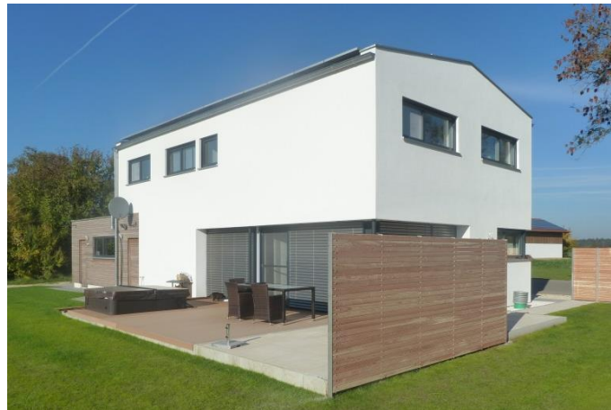
Abbildung 4.3: Außenansicht des Einfamilienhauses (Süd-Westseite) (Datenquelle: [181])
