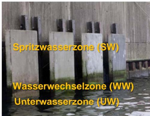
Bild B.5: ausgelagerte Verbundplatten an der Ostseeküste
