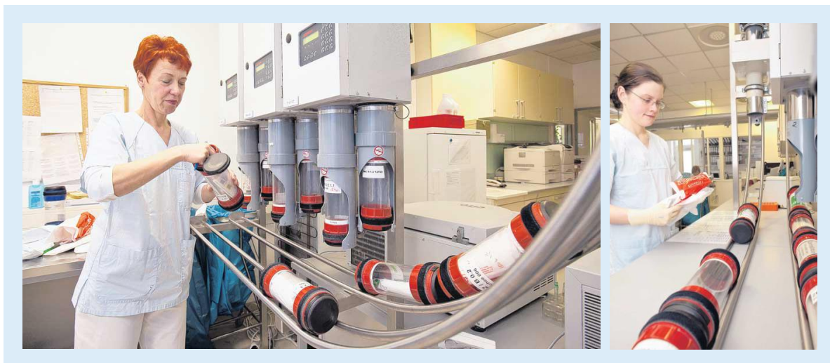
Abbildung 5-13: Rohrpostanlage in einem Krankenhaus [Sch-2010b, S. 1ff.]
