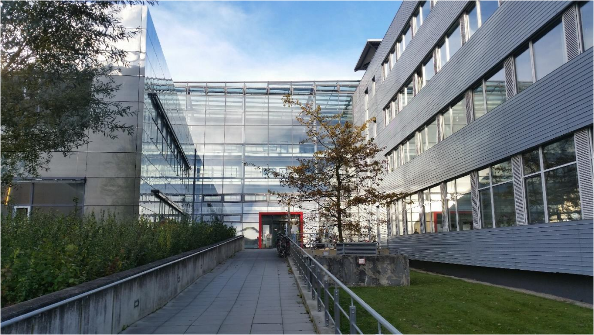
Abb. 4.23/24: Südeingang zwischen Bibliothek und Gebäudeteil 12
