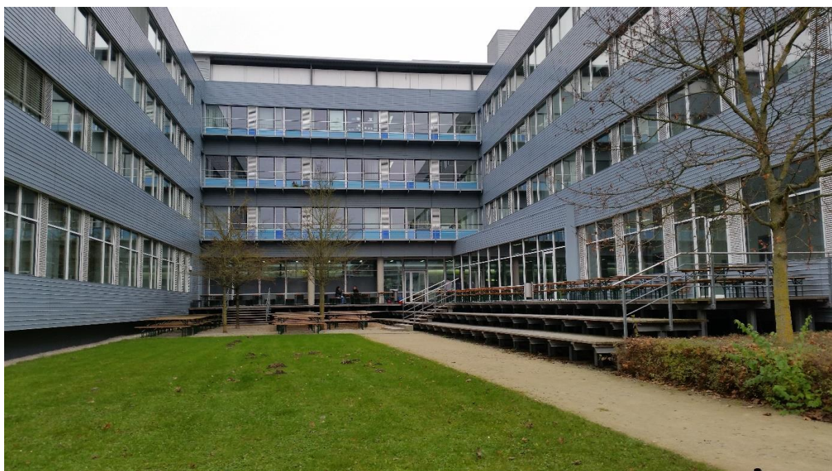
Abb. 4.21/22: Terrassenbereich der Cafeteria zwischen den Gebäudeteilen 8 und 10
