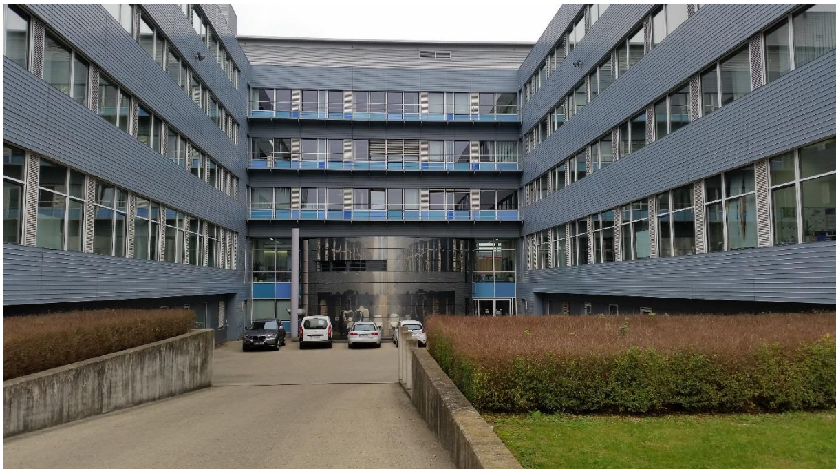
Abb. 4.19/20: Anlieferhof und Hörsaal 3 im Innenhof zwischen Gebäudeteil 6 und 8
