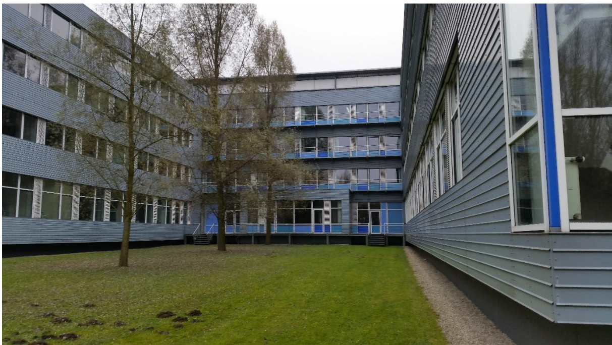
Abb. 4.27/28: Innenhof zwischen den Gebäudeteilen 11 und 13
