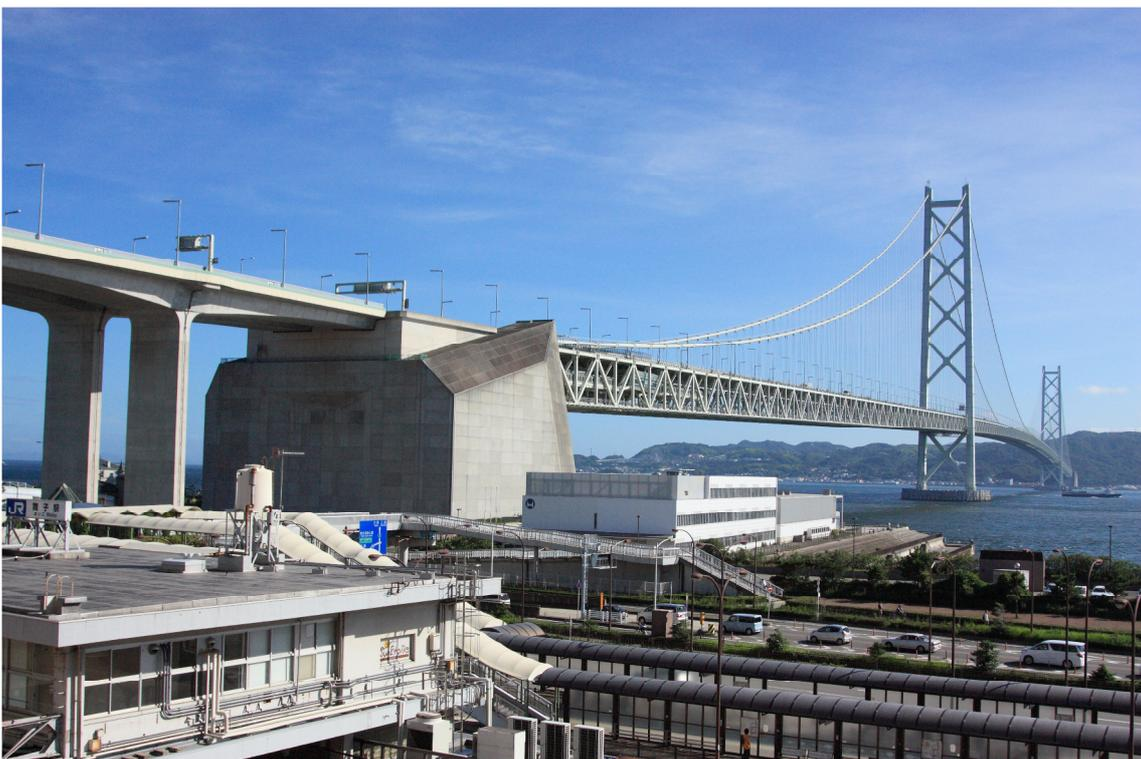
**Abbildung 2-15:** Die Akashi-Kaikyo Brücke in Japan – Das erste Bauwerk, bei dem PCE-Beton zum Einsatz kam [97]
