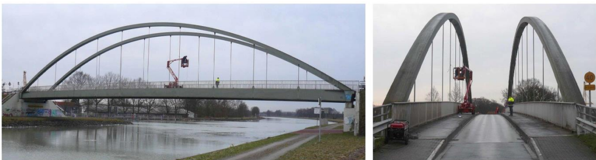
Abbildung 7-1: Ansichten der Gelmer Brücke (während Schwingungsmessungen)
