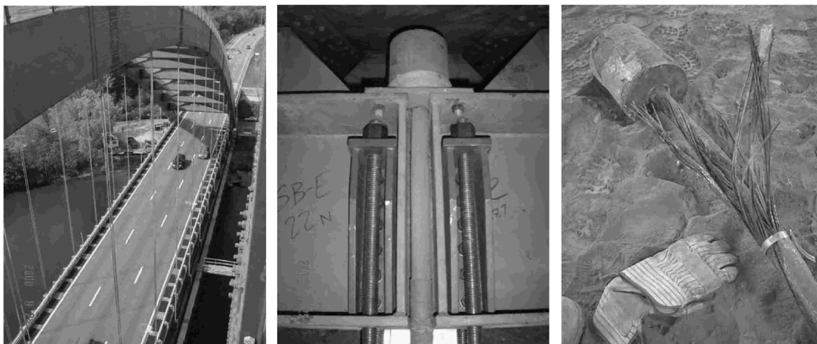
Abbildung 3-18: Schäden an Seilhängern einer Bogenbrücke nach Martin und Blabac
