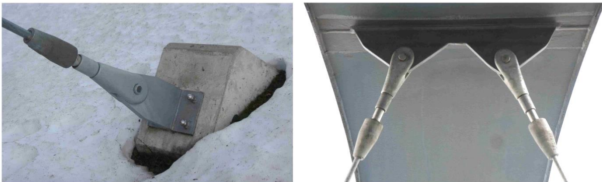
Abbildung 1-2: Beispiele von Seilendverankerungen mit Bolzenanschluss
