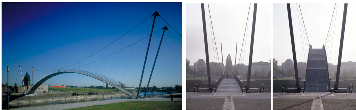
Abb. 3: Wandelbare Fußgängerbrücke in Duisburg, www.sbp.de [72]
