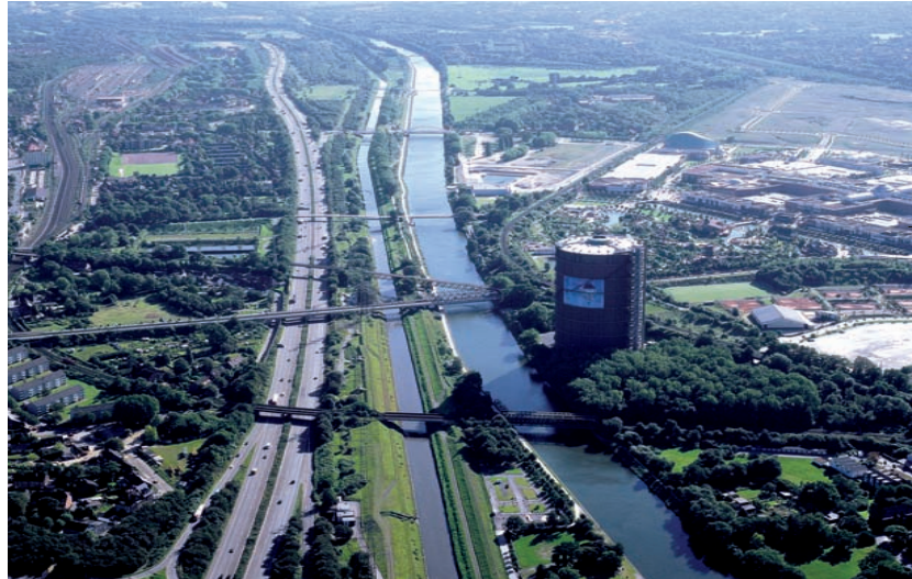
Abb. 76 | Das Emschertal ist durch eine räumliche Bündelung von Infrastrukturen geprägt. Das Bild zeigt die Autobahn A 42, die Emscher mit der Emscherinsel und dem Emscher-Kanal. (Quelle: EGLV)
