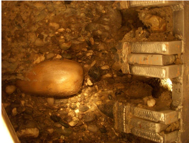
Abb. 49: Blick durch eine Schneiradöffnung auf die Ortsbrust in steinigen, blockigen Kiesen. Das Schneirad ist mit Schälmessern und vorlaufenden Sticheln bestückt. Der links der Bildmitte sichtbare Stein in der Ortsbrust wurde durch die Stichel freigelegt, aber nicht abgebaut
