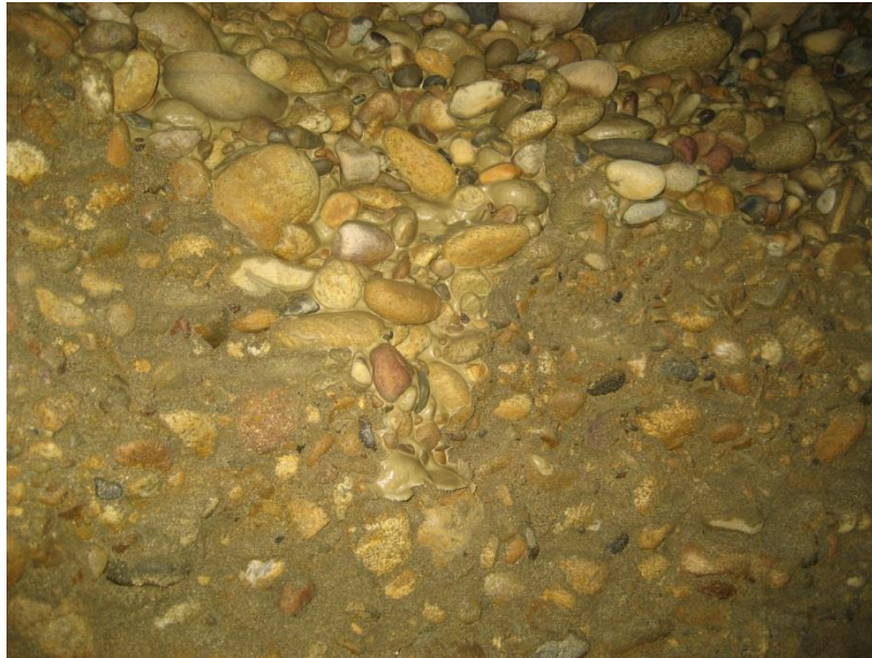
Abb. 54: Blick auf die Ortsbrust in mittel dicht gelagerten, sandigen Kiesen beim Abbau mit Schälmessern ohne vorlaufende Schneidrollen. Der Filterkuchen ist unterhalb der Bildmitte entfernt. Die Ortsbrust ist leicht uneben. Es sind keine Schneidspuren der Schälmesser erkennbar. Bildausschnitt: ca. 40 cm auf 50 cm. (Herrenknecht AG)
