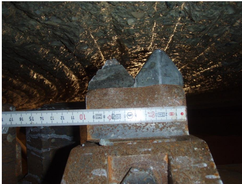
Abb. 51: Blick auf einen Stichel und die Ortsbrust in Abbau einer Dichtwand aus stahlbewehrtem Beton mit ca. 35 MPa Würfeldruckfestigkeit. Die Ortsbrust zeigt Furchen, die mit der Form der Hartmetallzähne am Stichel übereinstimmen. Der linke Hartmetallzahn des Stichels weist einen Spröbruch auf, der durch die Stahlbewehrung verursacht wurde.
