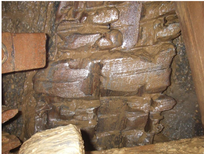
Abb. 46: Blick durch eine Schneiradöffnung auf die Ortsbrust mit einem Stahlträger, der in Beton eingebunden ist. Am Stahlträger sind deutlich die Spuren der Schneidrollen sichtbar. Der Stahlträger wird durch die Abbauwerkzeuge deformiert, aber nicht abgebaut. (Herrenknecht AG)
