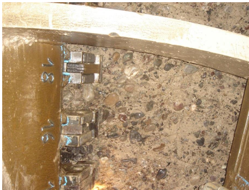
Abb. 38: Blick auf die Ortsbrust durch eine Schneidradöffnung in mitteldicht gelagerten sandigen Kiesen. Der Bodenabbau erfolgt mit vorlaufenden Schneidrollen und nachlaufenden Schälmessern. Die Schneidspuren der Schneidrollen sind nur sehr undeutlich in der Ortsbrust zu erkennen. (Herrenknecht AG)
