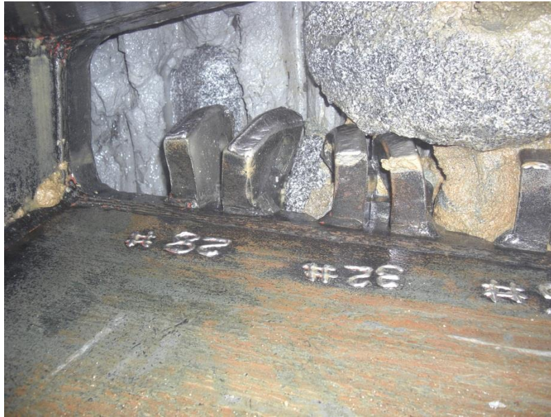
Abb. 58: Blick durch eine Schneiradöffnung auf Schälmesserhalter und Ortsbrust in tonigen Schluffen mit eingelagerten Granitblöcken. Die Schälmesser auf den sichtbaren Spuren Nr. 28 & 32 fehlen aufgrund von Sprödbrüchen der Schälmesser und Befestigungselemente vollständig. Die zugehörigen Schälmesserhalter wurden durch die eingelagerten Blöcke stark deformiert. (Herrenknecht AG)
