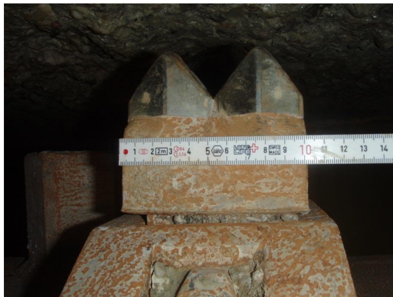
Abb. 67: Stichel bei der Messung in der Ortbetonwand. Der Meterstab dient als Maßstab für das Bild. Die Messung der Höhe der Hartmetallzähne wurde mit einer elektronischen Schieblehre auf \pm 0,1 mm genau vorgenommen.
