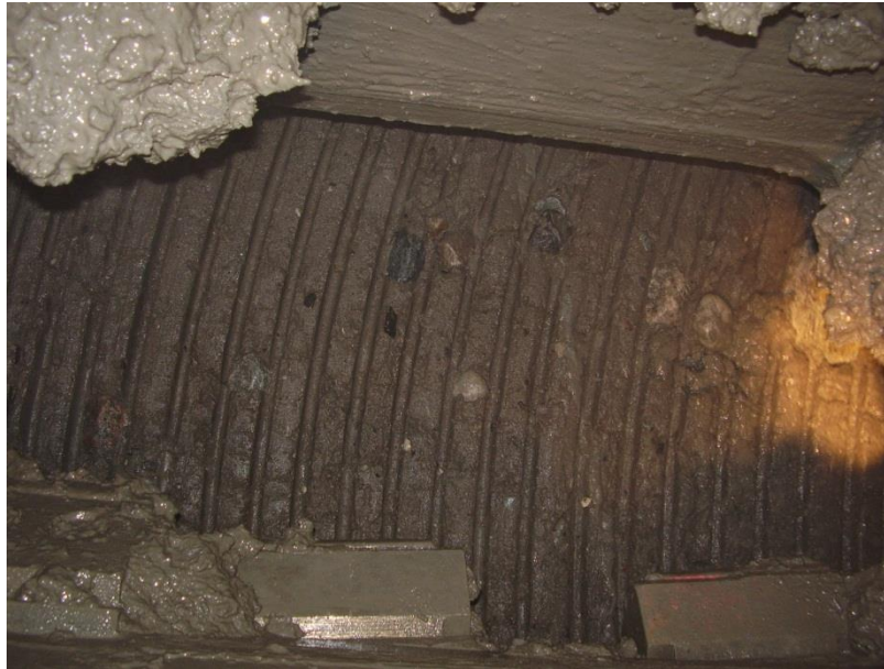
Abb. 37: Blick auf die Ortsbrust durch eine Schneidradöffnung in feinkörnigem Geschiebemergel mit eingelagerten Kieskomponenten. Die Schneidspuren der Schneidrollen werden durch den Boden in der Ortsbrust exakt nachgebildet. (Herrenknecht AG)
