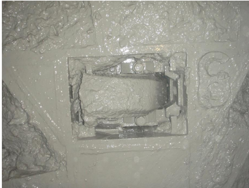
Abb. 42: Verklebtes Schneidrollengehäuse während einem Drucklufteinstieg. Auch die angrenzenden Schneiradöffnungen sind mit abgebautem Boden verklebt. Das Verklebungsmaterial wird zum Teil durch die Öffnungen im Schneidrollengehäuse gepresst und bildet dessen Form nach.
