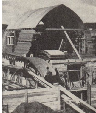
Abb. 50: Bauweise Kolb in Bauausführung und fertiggestellter Rohbau [Kersten, 1926]
