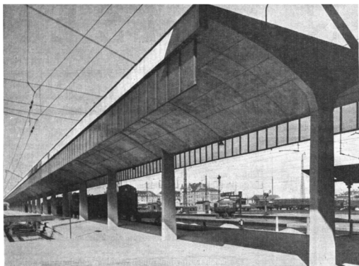
Abb. 21: Bahnsteigdach am Ostbahnhof München [Dischinger & Finsterwalder, 1932]
