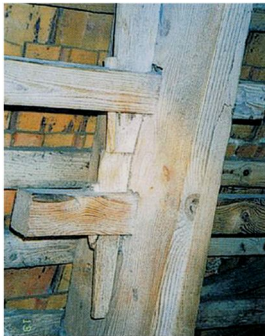
Abb. 25: Bogen mit Querriegel [Erler, 2009]
