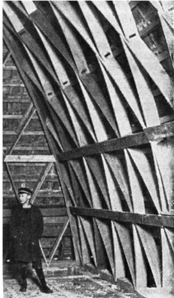
Abb. 43: Spitzbogendach in Zollbauweise [Kersten, 1926]
