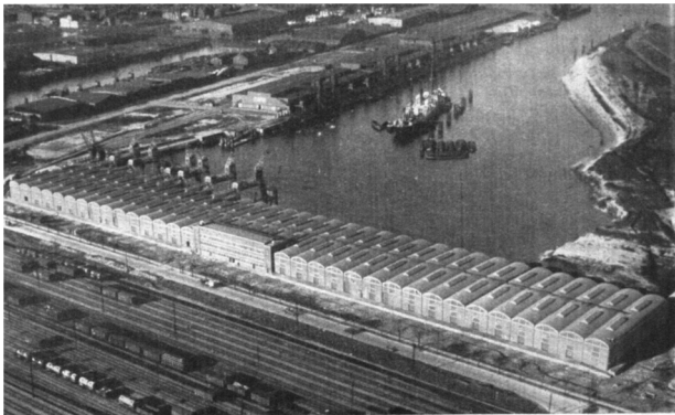
Abb. 19: Kaischuppen 59 Hamburg [Dischinger & Finsterwalder, 1932]
