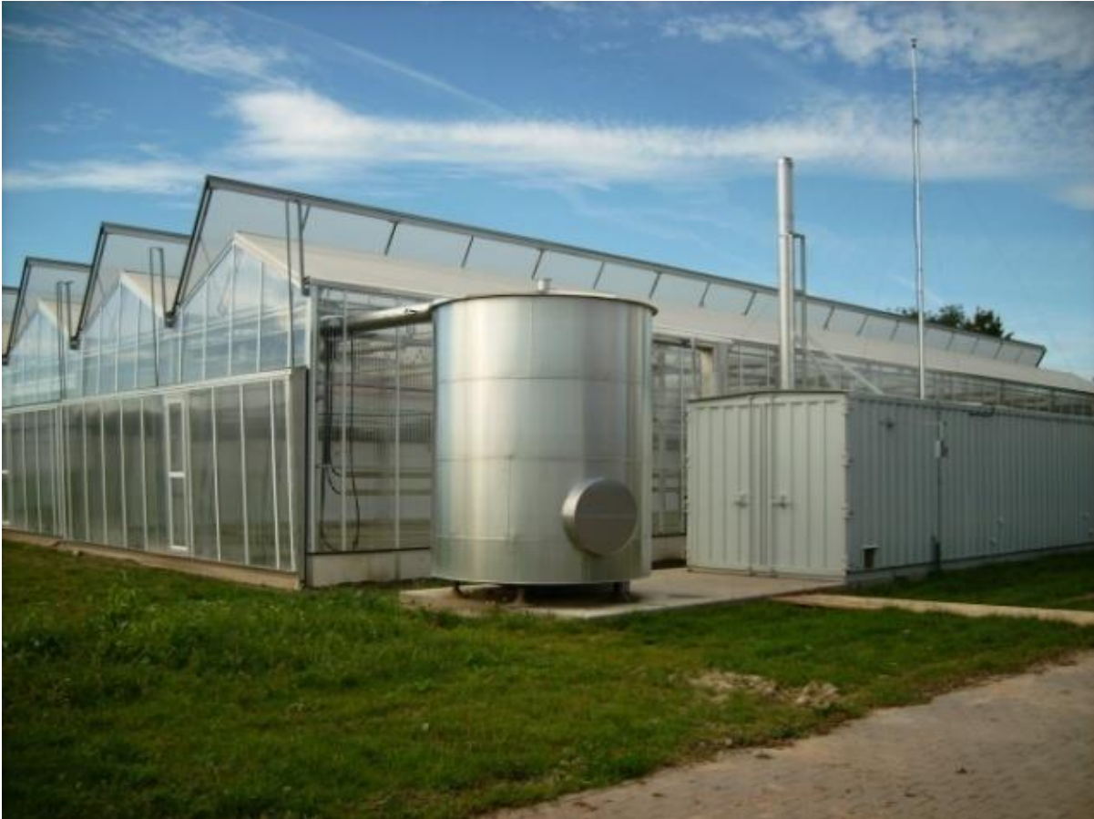
Abbildung 6: Heizcontainer mit Wärmespeicher (KREUZPAINTNER et al., 2011)
